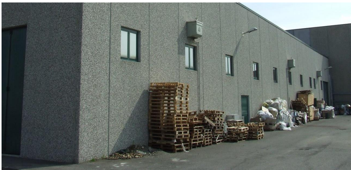
Vista sul lato esterno del magazzino dalla parte del “bene”.
