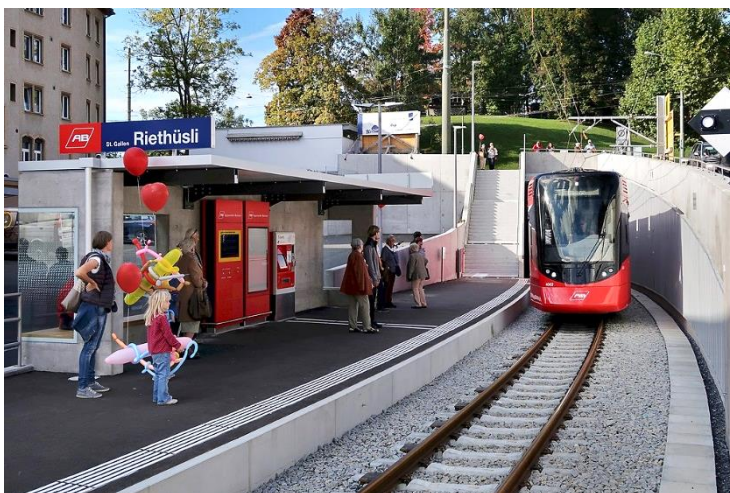
Fig. 4.11 Stadler Tango presso la fermata di Riethüsli all’imbocco del tunnel Ruckhalde
