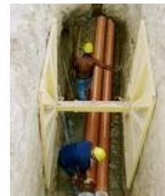
Fig. 3.4 Armatura di sostegno
