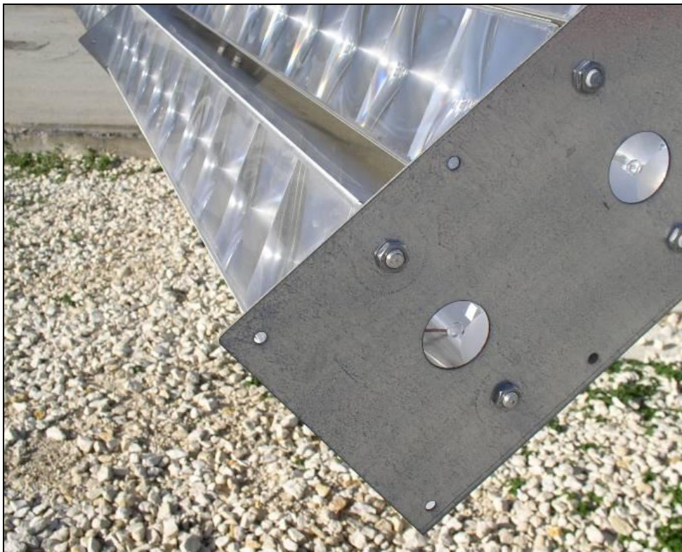
Figura 6.23 - Inclinazione relativa tra il modulo e la griglia di supporto.
