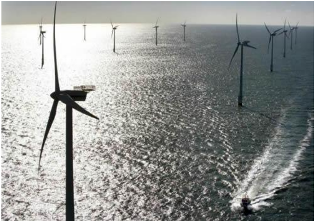
Figura 1.13 – Esempio di centrale eolica off-shore.
