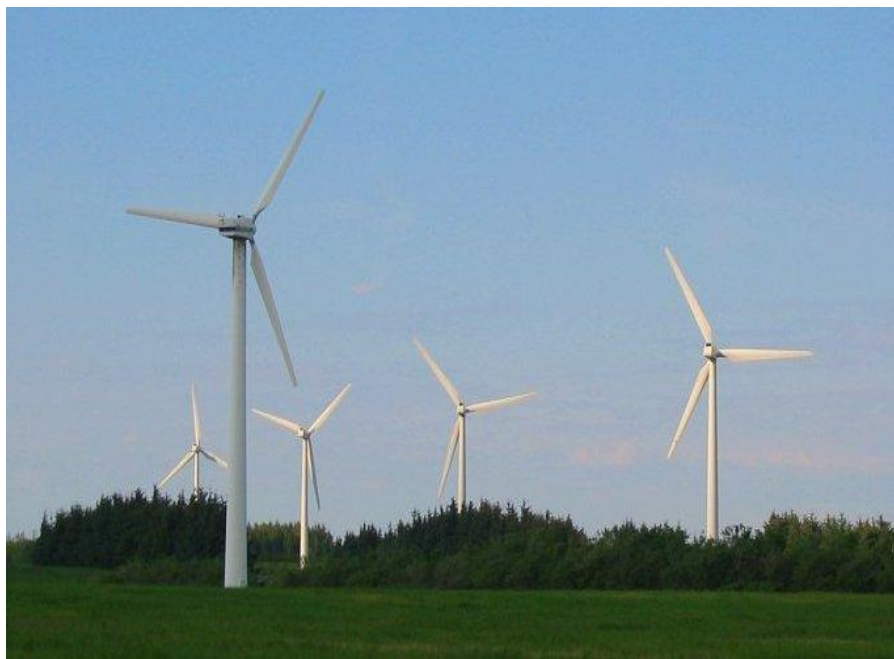
Figura 1.12 – Esempio di centrale eolica.
