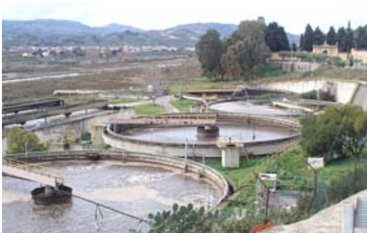
Immagine 03 - Esempio di impianto di depurazione (fonte internet)
