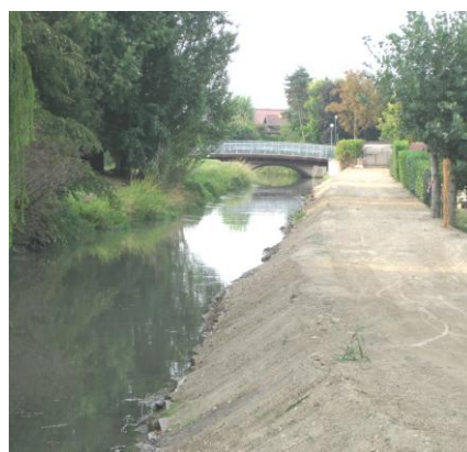
Parco dei due Tioni – Comune di Erbè – Manutenzione degli argini
