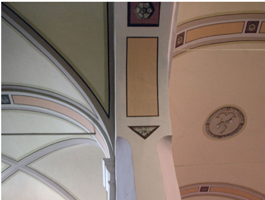
Fig. 539. Particolare delle volte sulle navate adiacenti.
