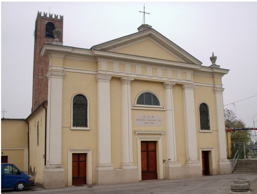
Fig. 530. La facciata sud della chiesa di Santa Cecilia Vergine e Martire.
