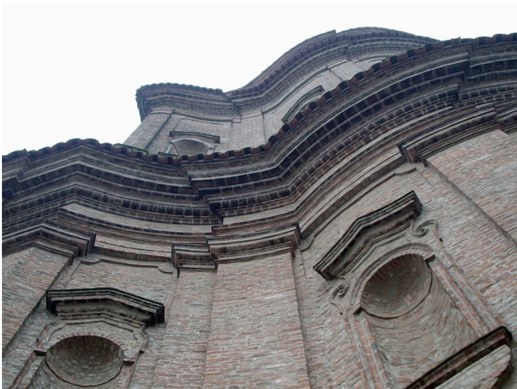
Fig. 304. Porzione di muratura in facciata.
