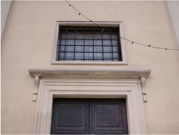
Fig. 429. Particolare di una porta laterale.
