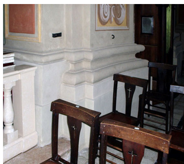
Fig. 112. Curvatura delle pareti e delle lesene.
