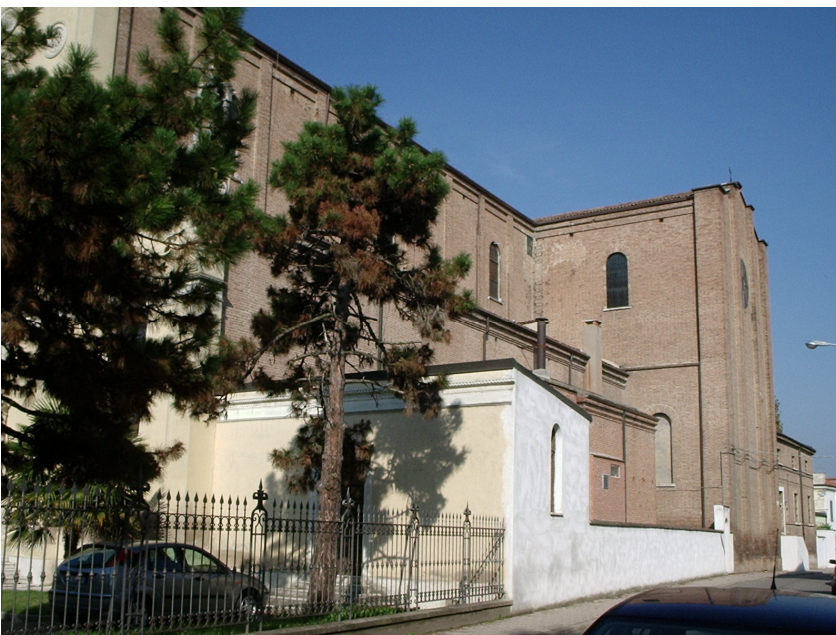
Fig. 37. Il fianco della chiesa verso via San Giuseppe.
