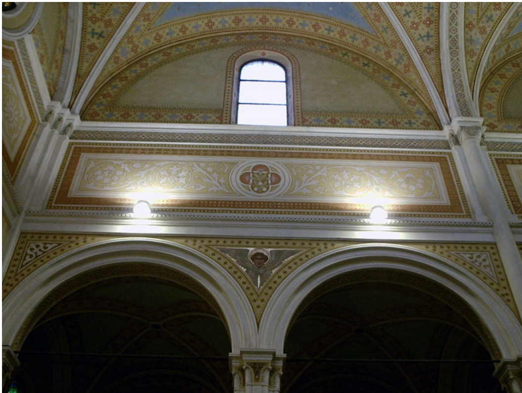
Fig. 43. Il sistema delle volte. La prima campata verso l'ingresso principale.
