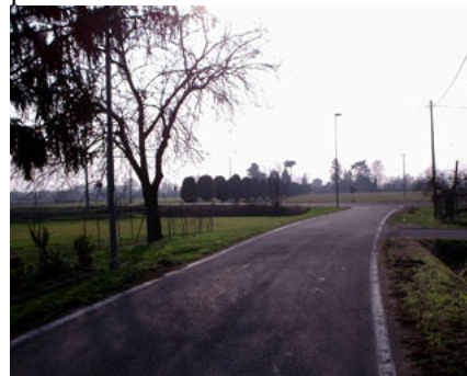
Fig. 319. Strada Mazzaloe verso il cimitero.
