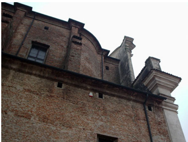
Fig. 107. Fronte nord verso via Cavour.
