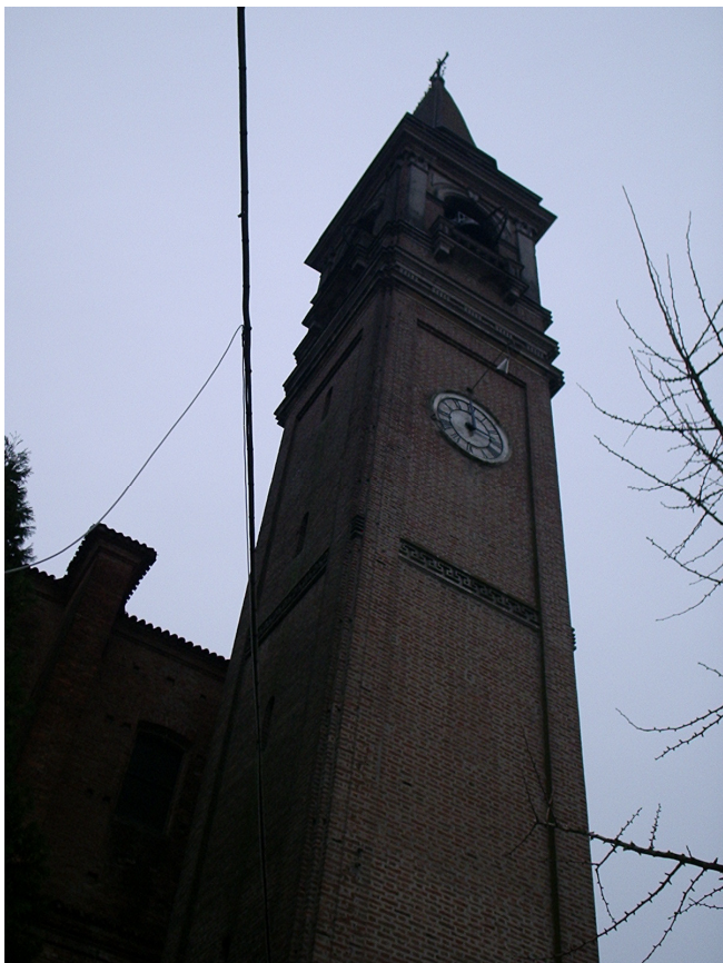
Fig. 385. Il campanile novecentesco.
