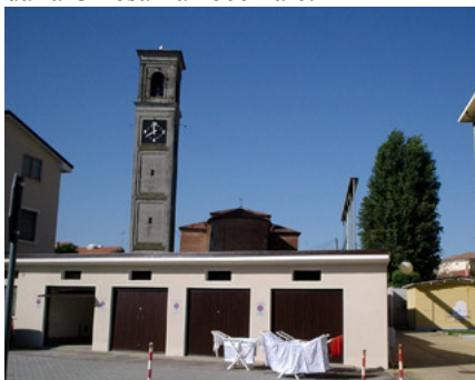
Fig. 163. Il campanile e l'abside della Parrocchiale visti dalla Piazza retrostante.
