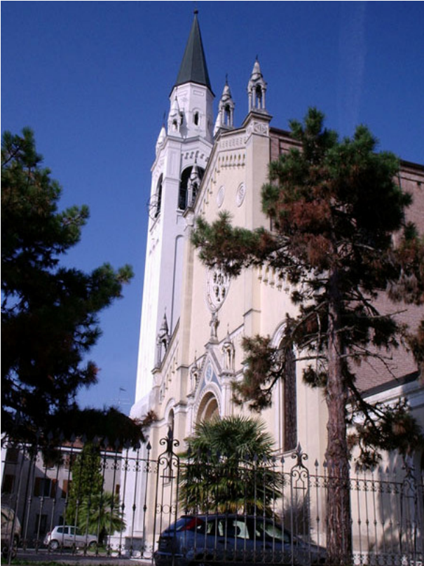
Fig. 35. La facciata principale vista da via San Giuseppe e il campanile.
