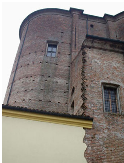
Fig. 130. La muratura sul fronte nord della chiesa. Le riseghe del mancato completamento.
