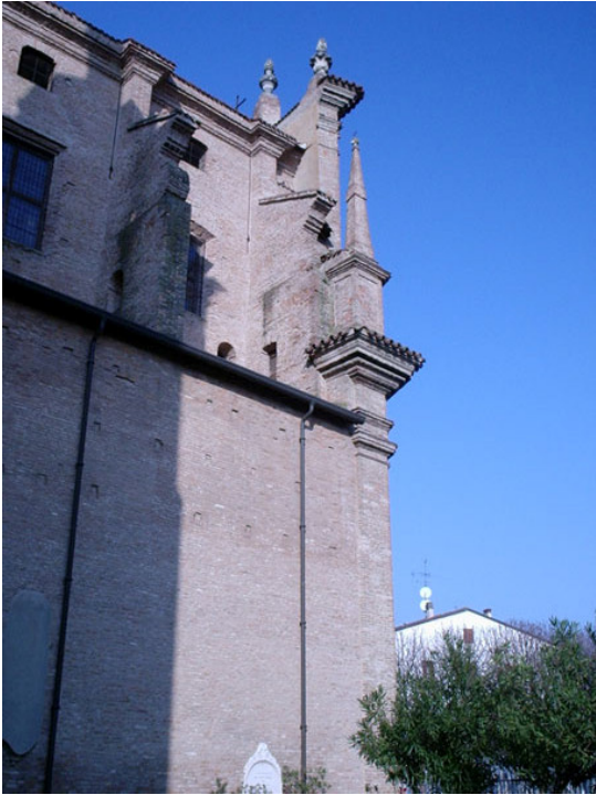
Fig. 281. La facciata nord.
