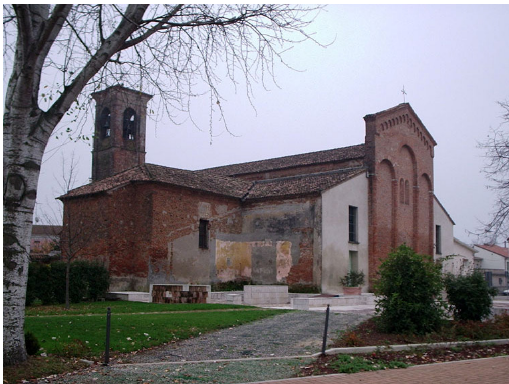
Fig. 224. La facciata della Parrocchiale di San Fiorentino Martire.
