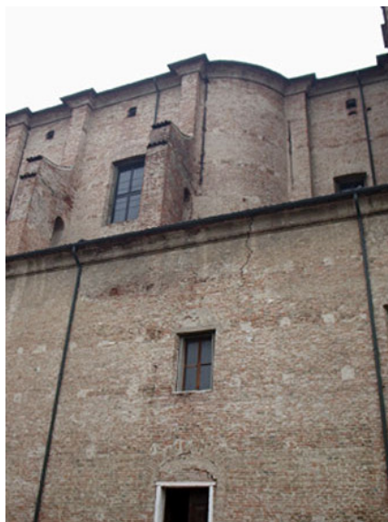
Fig. 131. Particolare dello stesso fronte con i capichiave.
