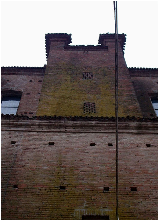
Fig. 404. La torre sul fianco destro della chiesa.
