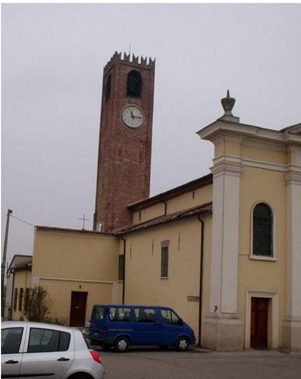
Fig. 531. Il fianco ovest della chiesa e il campanile.
