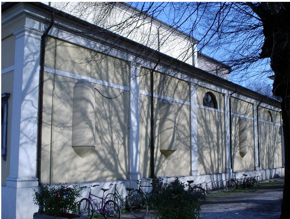
Fig. 564. Il lato sud della parrocchiale.
