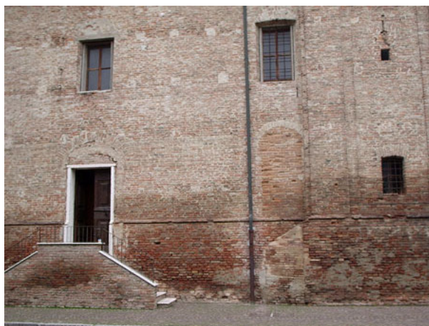
Fig. 119. Il rappezzamento della nicchia sul fianco nord della chiesa. Fig. 120. La porta tamponata sul fianco sud della chiesa.
