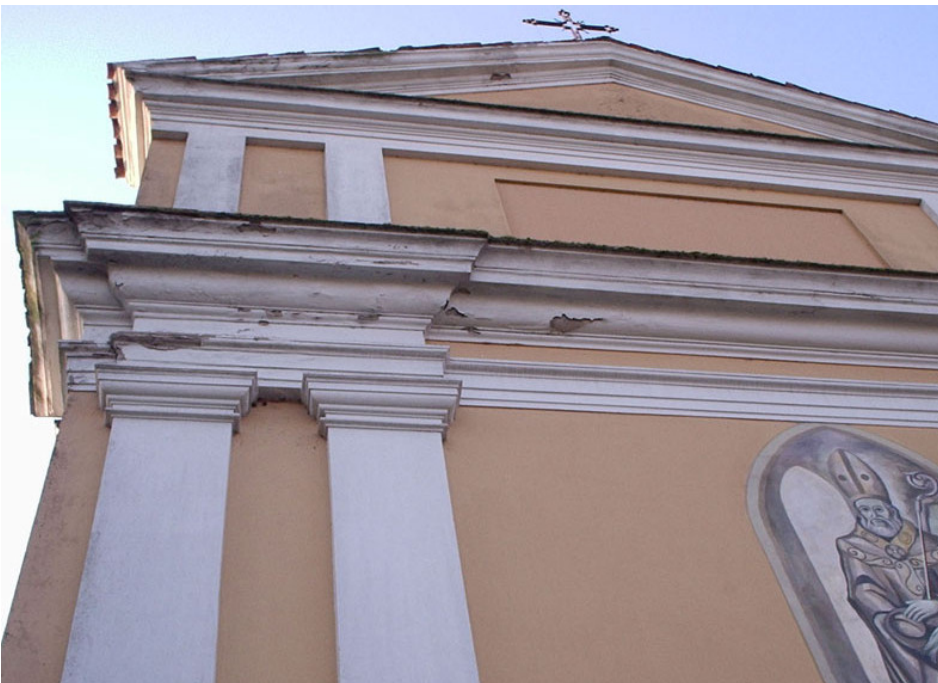
Fig. 345. La trabeazione della facciata principale.
