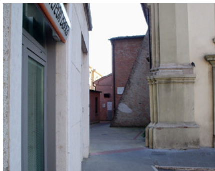
Fig. 161. La Piazzetta laterale della Chiesa Parrocchiale.
