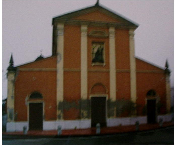
Fig. 457. La facciata prima degli ultimi restauri. Dall'Archivio parrocchiale.
