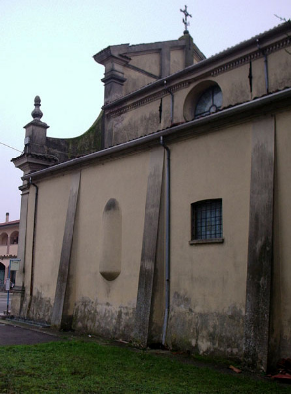
Fig. 440. Il sistema portante della chiesa.
