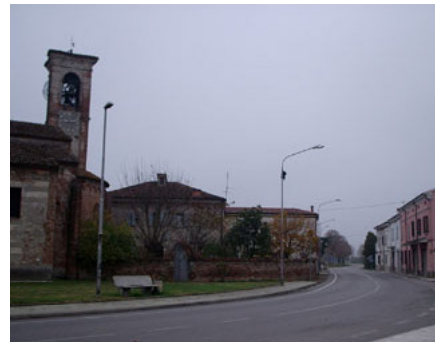
Fig. 220. La zona absidale e la casa canonica.
