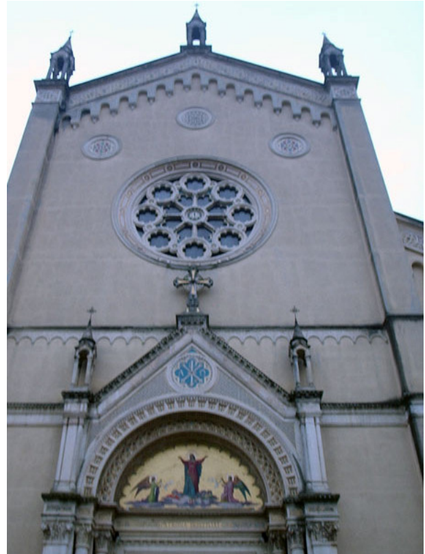
Fig. 36. Particolare della facciata principale.
