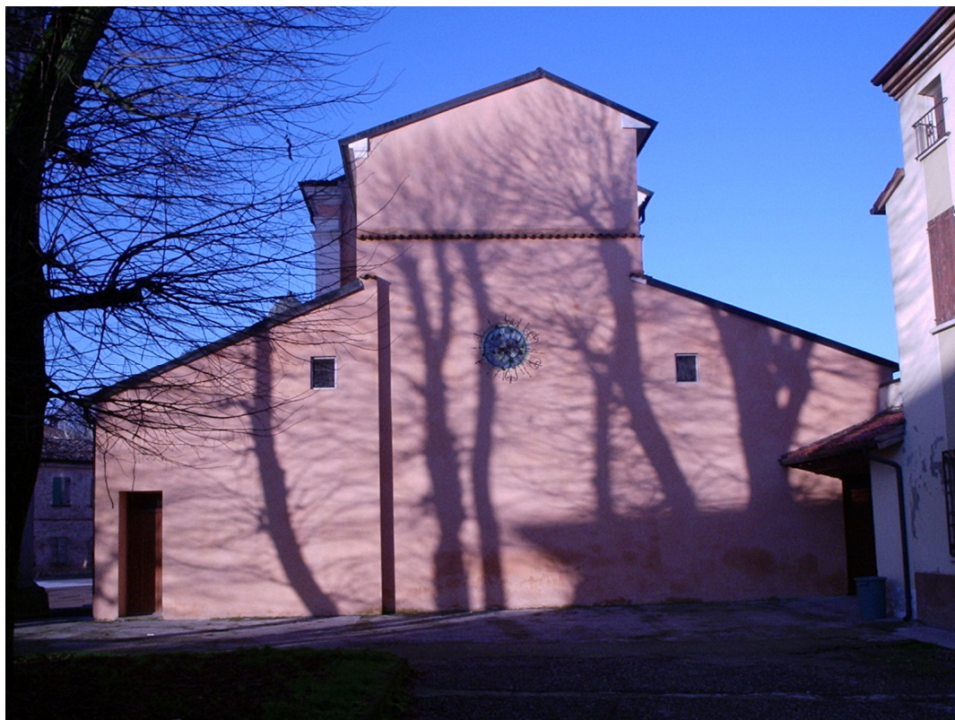
Fig. 459. La facciata est della chiesa.
