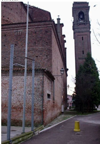
Fig. 376. Il lato ovest della chiesa.
