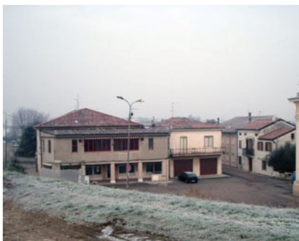
Fig. 527. Il piazzale davanti alla chiesa visto dall'argine.
