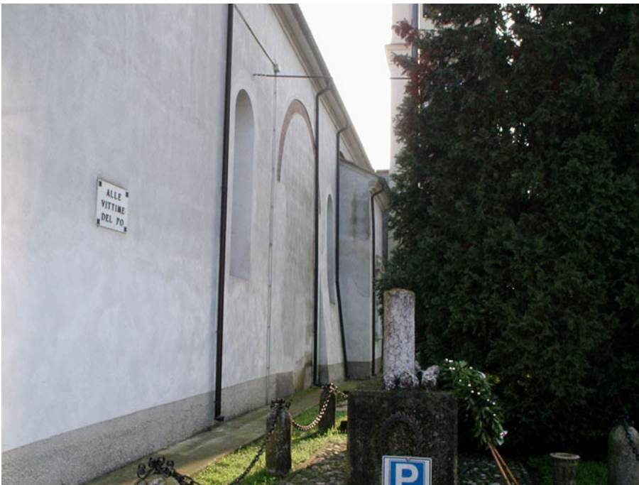
Fig. 321. La facciata est della chiesa.
