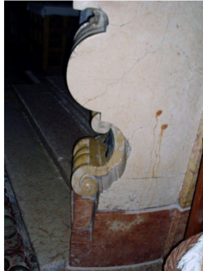
Fig. 140. Particolari costruttivi dell'Altar Maggiore: un modiglione da dietro.
