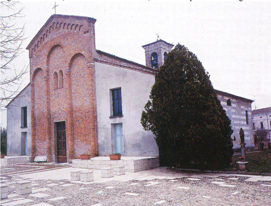
Fig. 210. Nuvolato, Chiesa di San Fiorentino, Facciata dopo la sistemazione del sagrato negli anni 1999-2002. Da Bussolotti C. 2005, p. 6.
