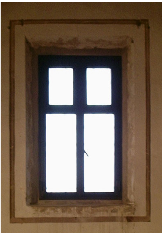
Fig. 232. La finestra in corrispondenza dell'altare della Trinità.
