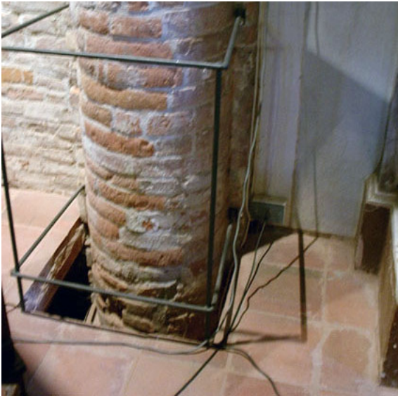
Fig. 248. Particolare di una soluzione del restauro che lascia intravedere il livello originale del piano di calpestio.
