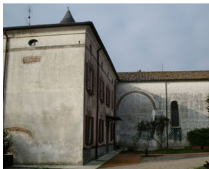
Fig. 315. Lato nord della casa parrocchiale.
