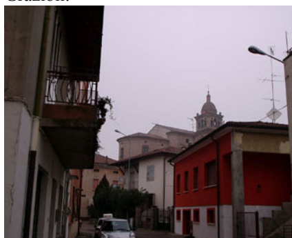
Fig. 279. Il lato ovest della chiesa.
