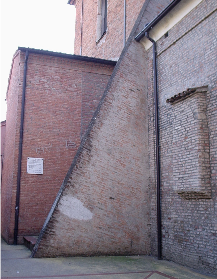
Fig. 194. Uno degli speroni di spalla costruiti nel primo '900.
