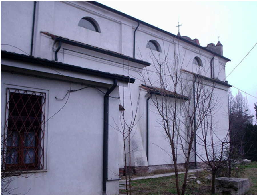
Fig. 496. Il lato ovest della chiesa.
