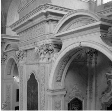
Fig. 702. Parrocchiale dell'Annunciazione, Sacchetta (MN) (1790), archi volanti.
