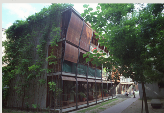
Comportamento stagionale della parete verde, Estate
