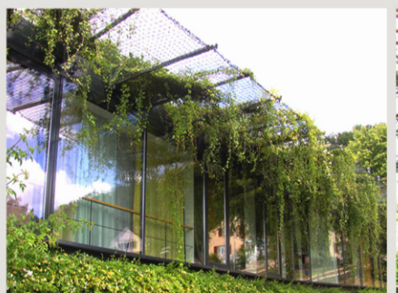
Viste sistema di schermatura orizzontale
