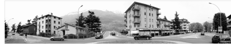
PANORAMICA (DIRETTRICE OVEST-EST)
