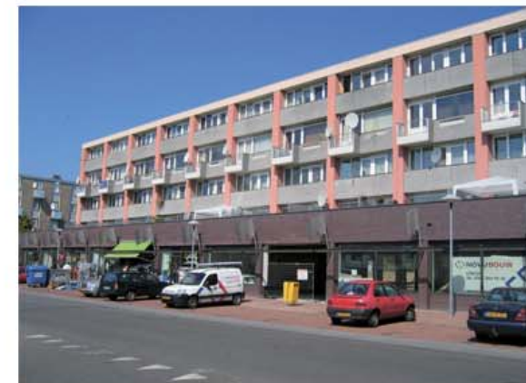
2. Centro commerciale Rijnbaan
