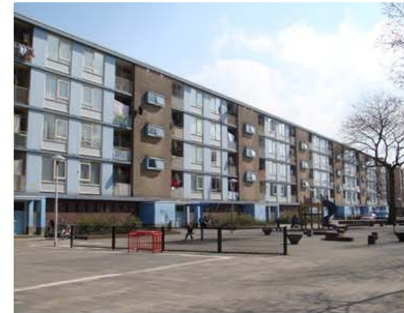
2. Edificio a stecca
