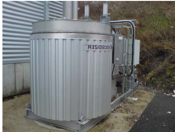
Fig 4.21 Ossidatore flameless (MEGTEC)
