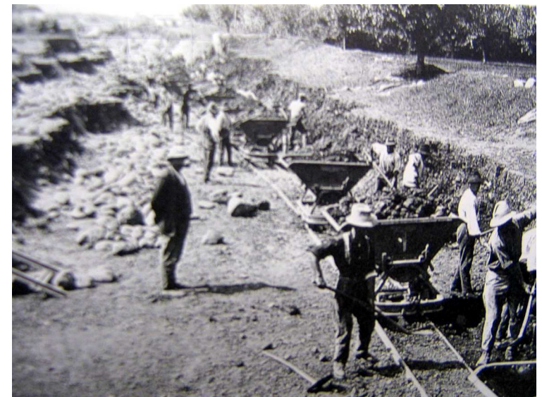
1927 Costruzione dell'autostrada A4
