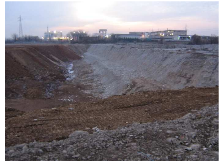
Ciglio dello scavo
