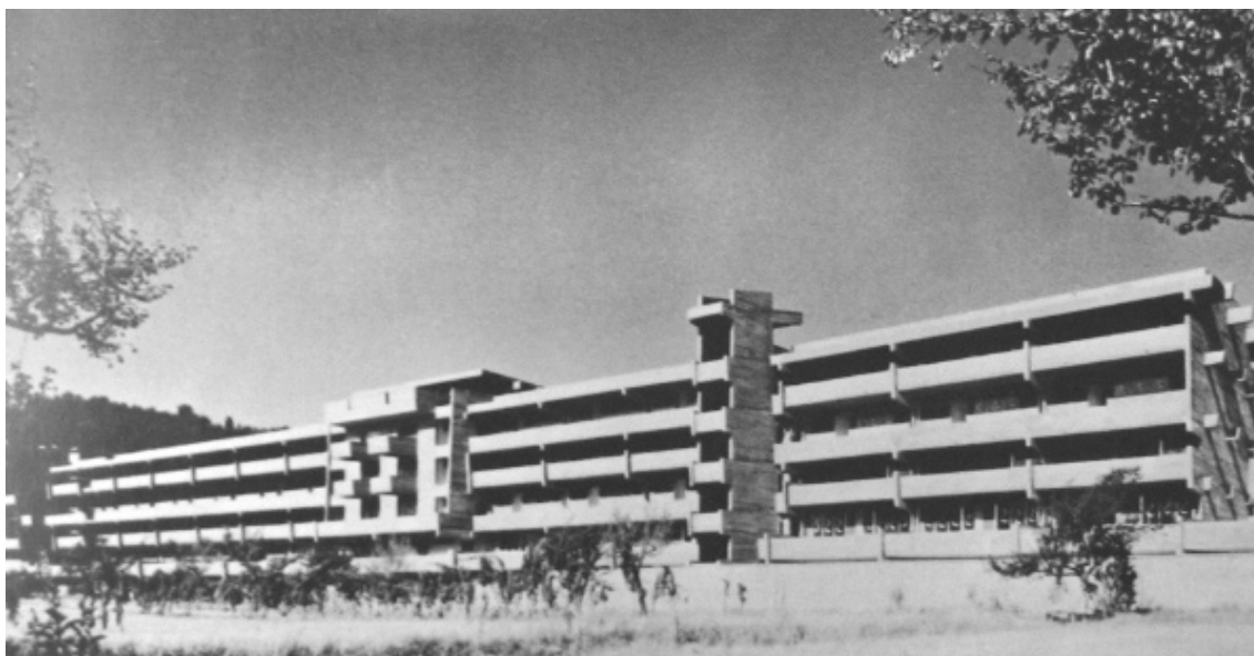
Figura 100. Veduta dell'Unità d'abitazione a Sorgane, Firenze, 1967 (Tratta da Architettura in Toscana 1931-1968 , Torino, 1968).
