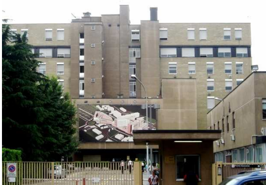
Figura 5.68: ingresso dell’edificio preesistente (Fonte: L. Gargioni).
