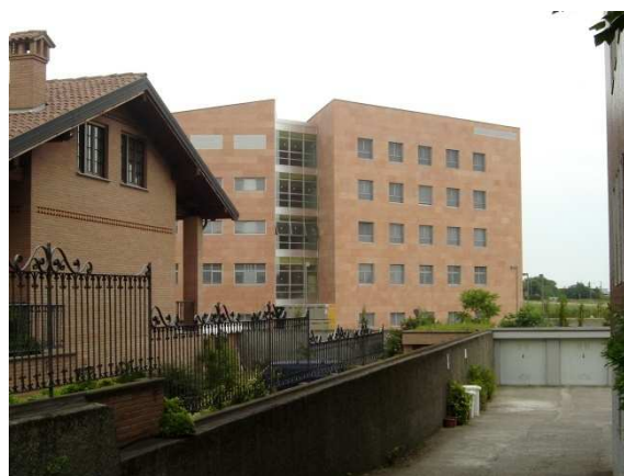
Figura 5.76: fronte ovest del blocco C (Fonte: L. Gargioni)
