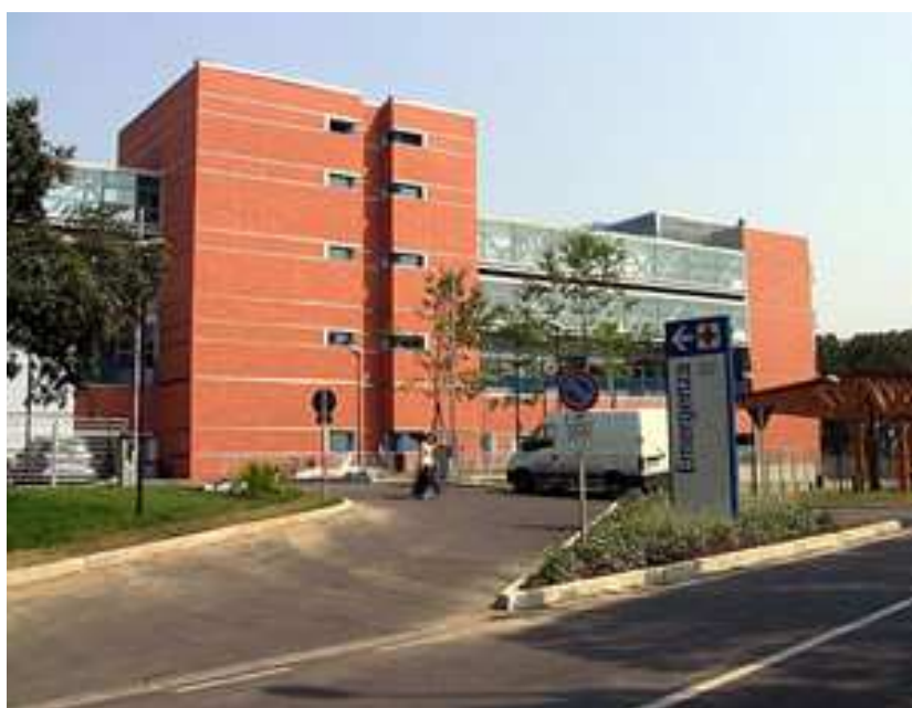
Figura 5.52: vista esterna dell'ospedale. (Fonte: www.prointec.it )
