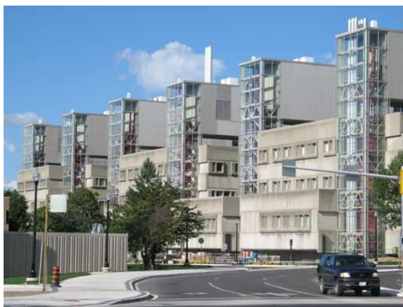
Figura 3.4: vista di uno dei fronti dell'edificio. Le torri vetrate costituiscono l'ossatura principale. All'interno sono collocate canalizzazioni verticali principali collegate ai piani tecnici e alcuni gruppi scala. È facile in questo modo creare ampliamenti e accrescimenti volumetrici con grandi margini di flessibilità interna distributiva.
