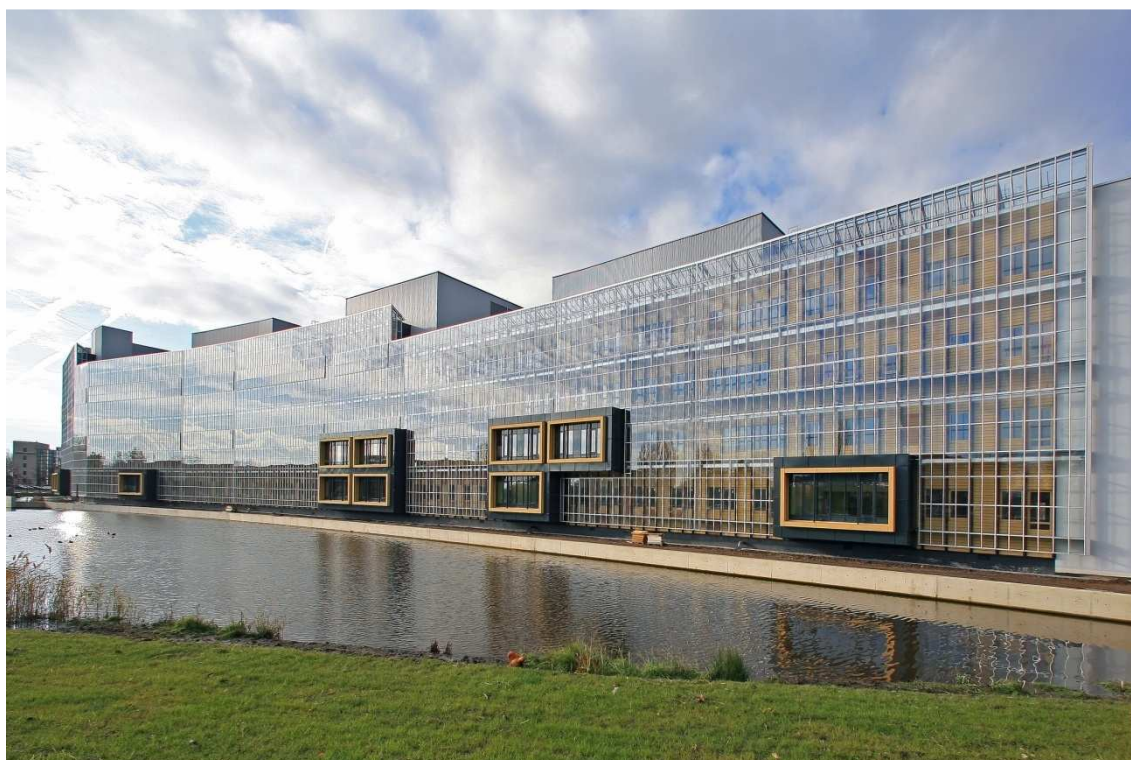
Figura 5.9: Vista della facciata sud-est, in evidenza i moduli che consentono di ampliare la superficie. (Fonte: foto R. Hoekstra).
