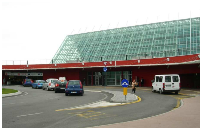
Figura 5.41: vista esterna degli accessi all’ospedale. (Fonte: propria).
