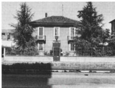
1984 Villa lungo la Martesana, presso Crescenzago.
