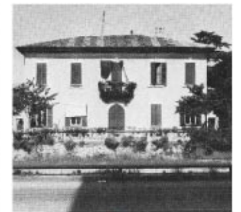
1984 Villa lungo la Martesana, presso Crescenzago.
