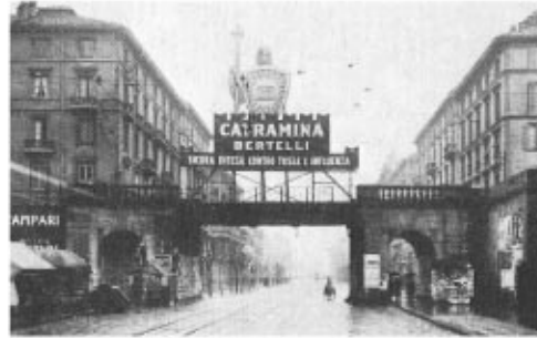
1933 Corso Buenos Aires: veduta verso il centro della città con il sovrappasso ferroviario.
