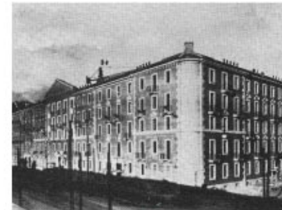
1929 Quartiere ATM Leoncavallo. Via Teodosio.
