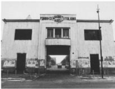
1922 Fabbrica Magneti Marelli di Crescenzago. Ingresso di via Adriano.
