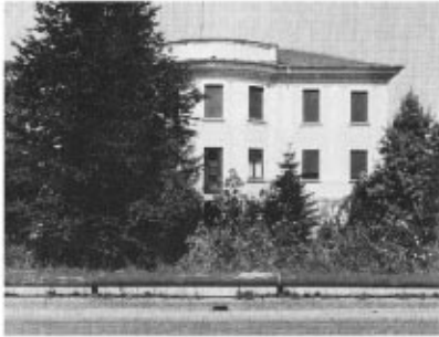
1984 Villa lungo la Martesana, presso Crescenzago.
