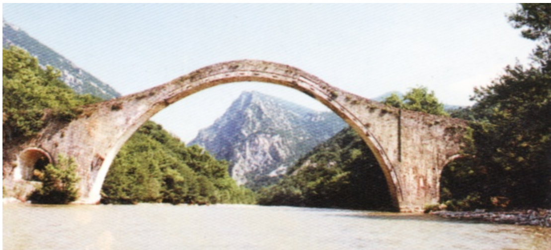
Fig. 2 - Il ponte di Konitsa (Regione di Ioannina)
