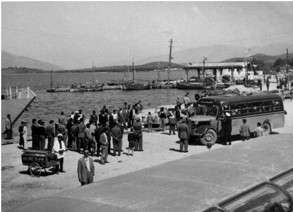
Fig. 2 – Ancora un'immagine parziale di Igoumenitsa negli'anni '50 con il porto.
