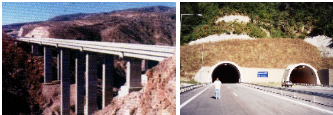
Fig. 1 - Immagini di un ponte e di una galleria sull'autostrada "Egnatia" (in fase di costruzione). Risulta ben visibile la geomorfologia di quasi tutto il territorio greco. Fonte: foto personali.
