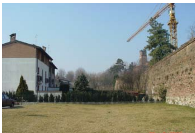
fig.5.37. Immagini della cinta e degli spazi a verde e del parcheggio adiacenti
