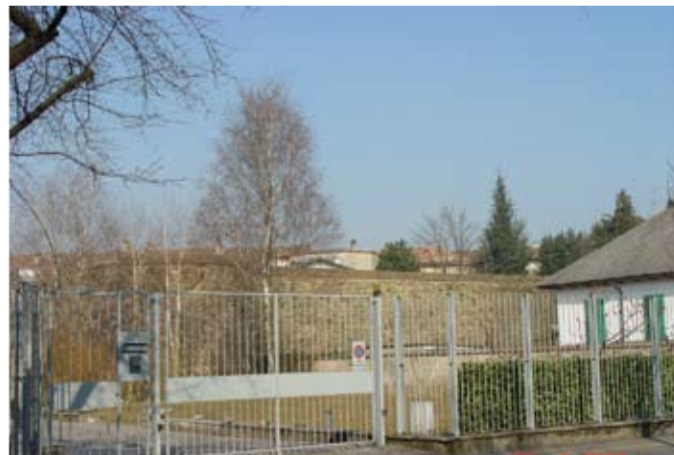
L'accesso al manufatto è impedito a causa della presenza di proprietà private tra le mura e la strada. L'esporsio di una fascia di terra a ridosso delle mura permetterebbe l'accesso alla struttura che si trova, ad oggi, in ottimo stato di conservazione.
