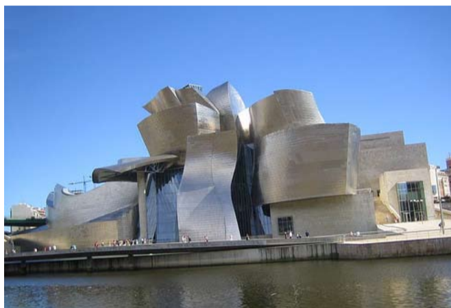
fig.4.3. Vista esterna del museo Guggenheim di Bilbao
