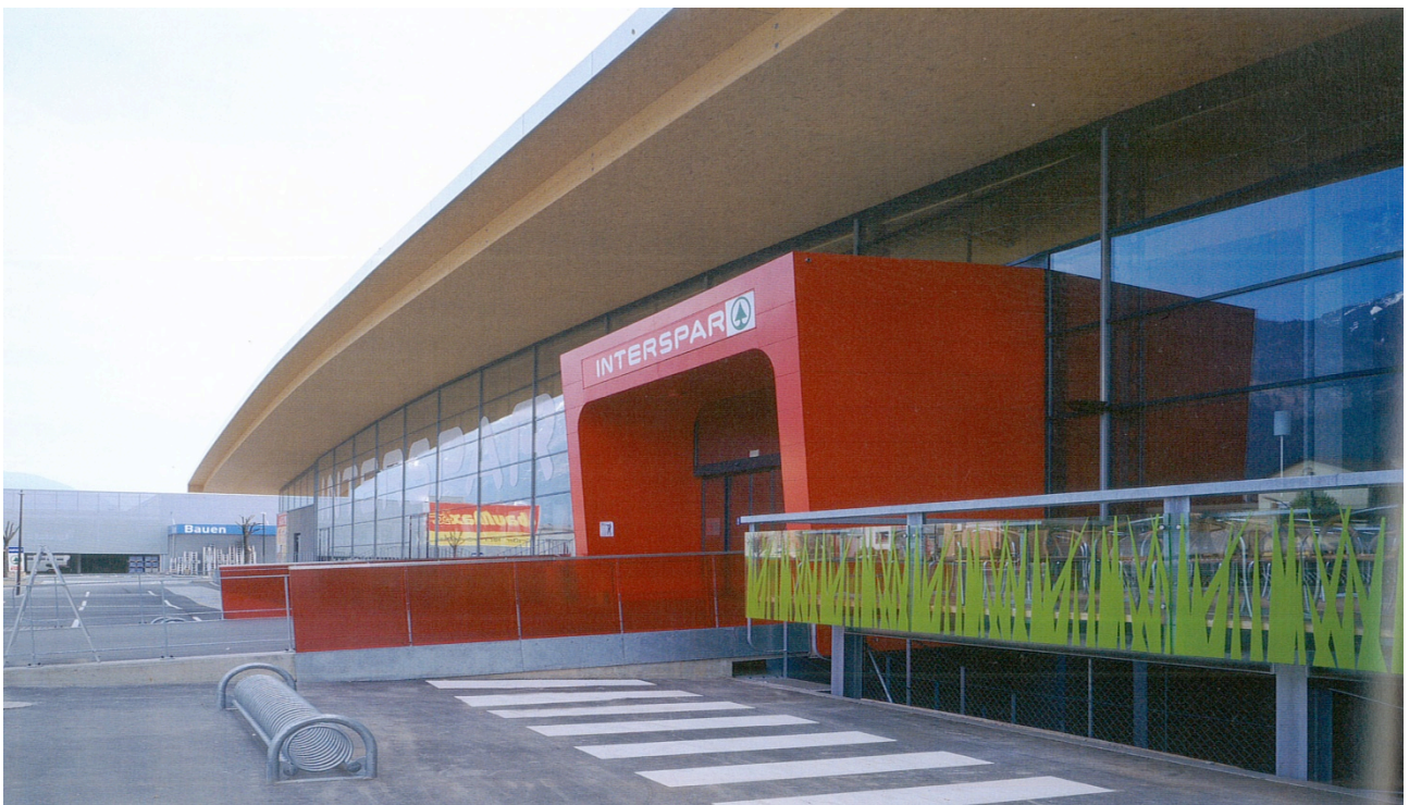
Fig. 5.2.2.2.5 Veduta dell'ingresso dell'ipermercato
