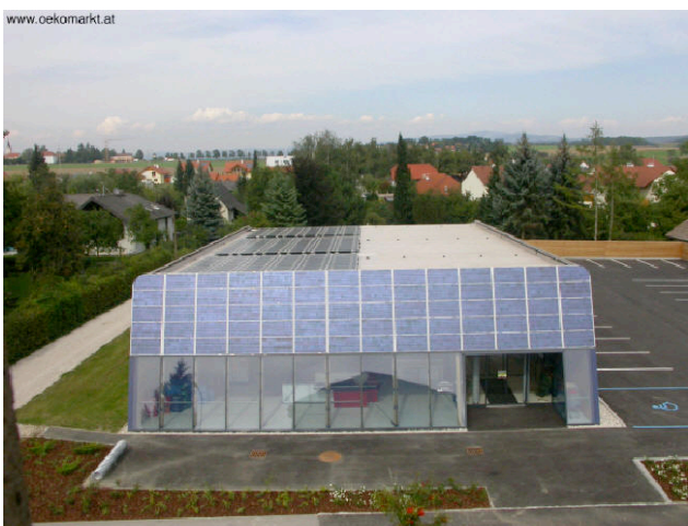
Fig. 5.2.2.15.8 e Fig. 5.2.2.15.9 Vedute dell'impianto fotovoltaico in facciata
