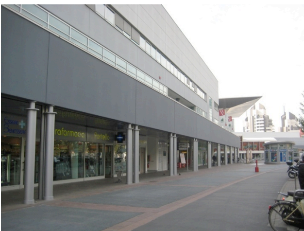
Fig. 5.2.3.6.9 e Fig. 5.2.3.6.10 Vedute degli edifici commerciali
