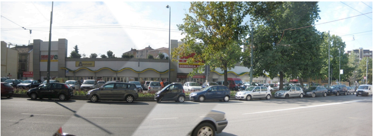
Fig. 5.2.3.7.6 Prospetto frontale della facciata ristrutturata
