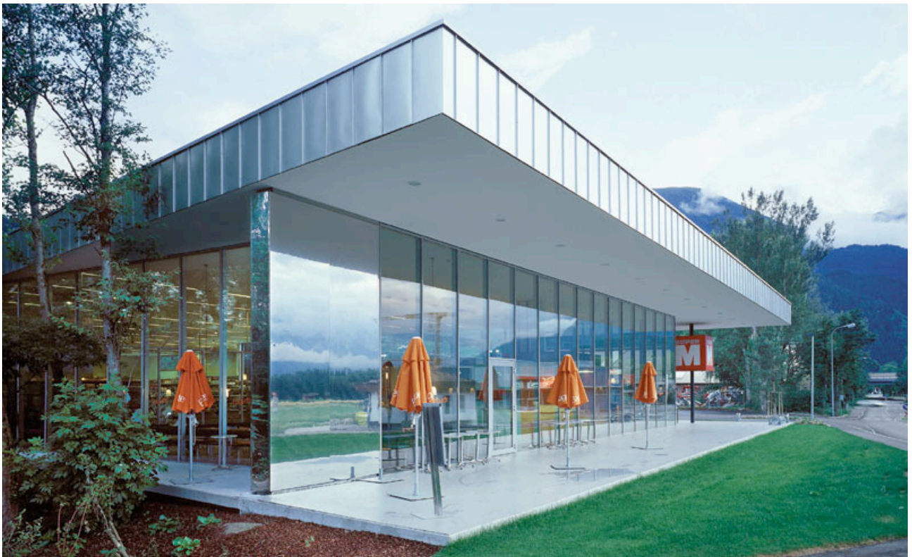
Fig. 5.2.2.14.6 Veduta del prospetto che è in direzione del lato strada
