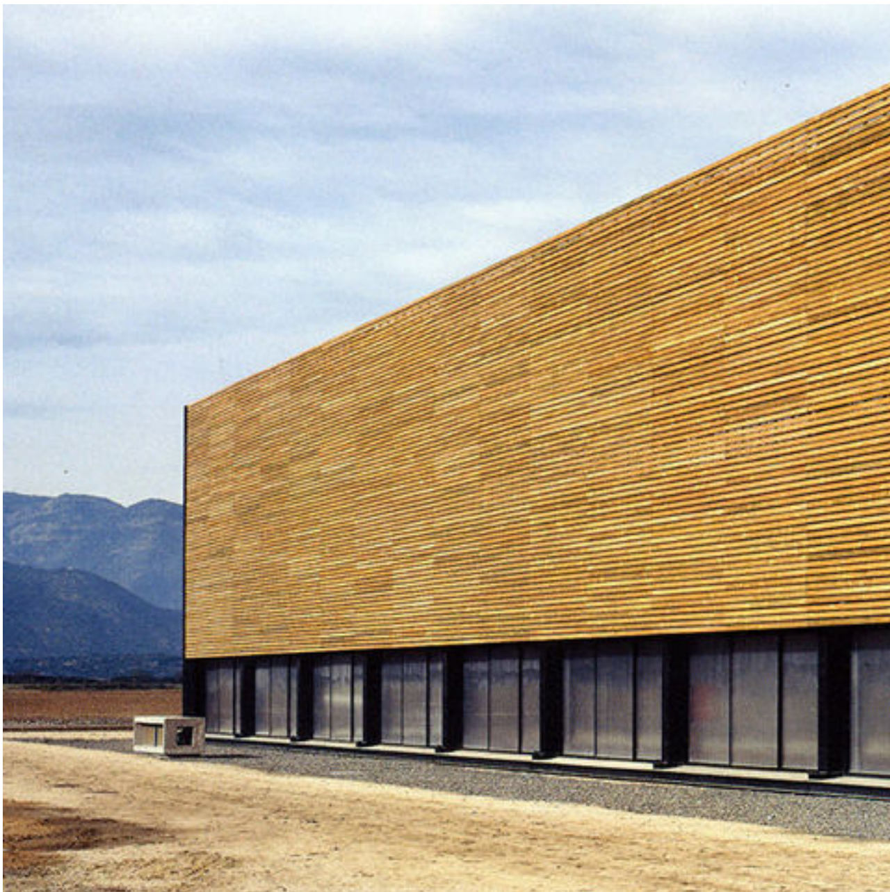
F.17 Vista del rivestimento ligneo esterno
