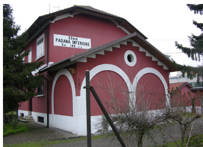
Vista della facciata a sud-ovest
