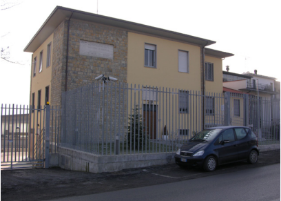
Vista dell'ex Casa Cantoniera dalla strada
