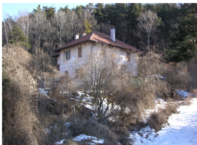
SS 49 Via Vecchia - Pusteria Sudtirolo (Bz) - Trentino Alto Adige
