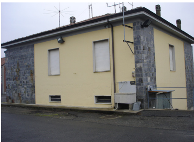
Vista della facciata a ovest
