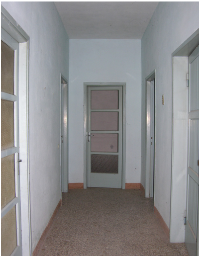
Corridoio al piano terra
