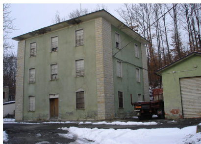
Vista della casa cantoniera dalla strada
