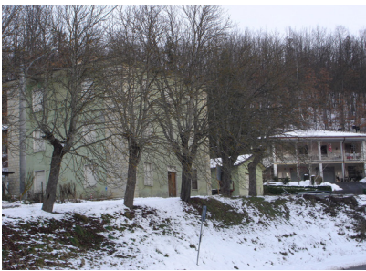
Vista della casa cantoniera dalla strada
