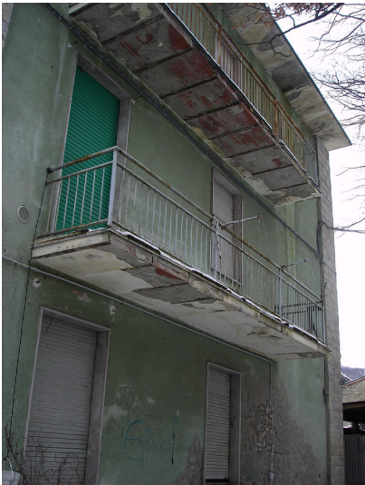
Vista dei balconi della facciata a nord
