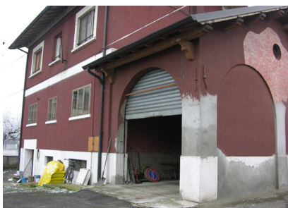
Vista del corpo annesso alla casa cantoniera
