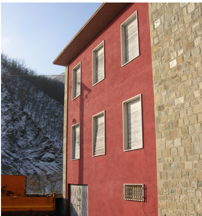
Vista della facciata a ovest
