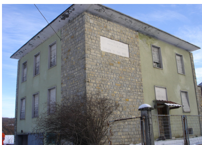
Vista della casa cantoniera dalla strada
