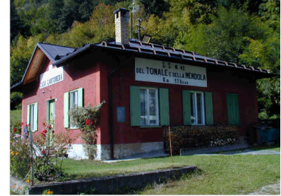
SS 42 del Tonale della Mendola localit  Commezzadura (Tr) - Trentino Alto Adige
