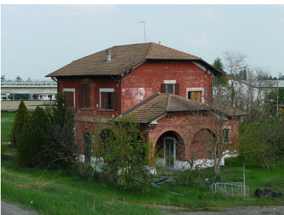
Casa cantoniera ex Anas sulla strada della Cisa
