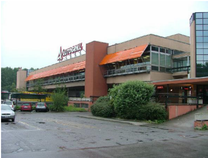
Stato attuale dell'Autogrill Dorno Ponte
