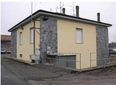
Vista della facciata a sud
