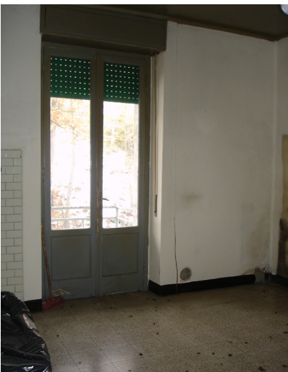
Vano al piano primo
