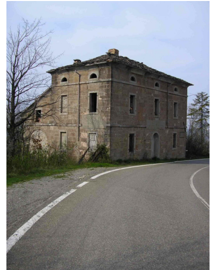
Casa cantoniera lungo la strada della Cisa
