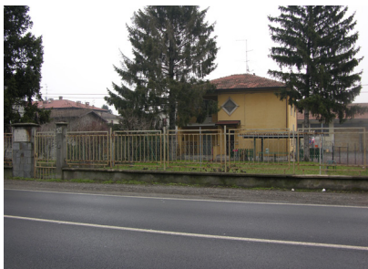
Veduta della casa cantoniera dalla strada
