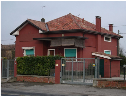
Casa cantoniera ex Anas sulla strada Alemagna
