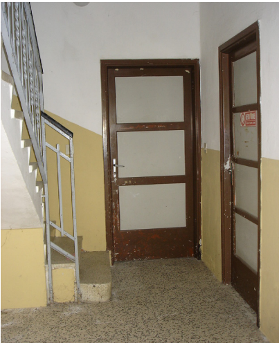
Vano scala a piano terra
