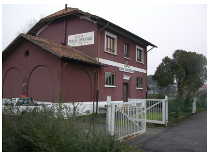
Vista della Casa Cantoniera dalla strada
