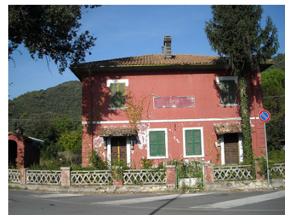
Casa cantoniera ex Anas sulla strada Flaminia
