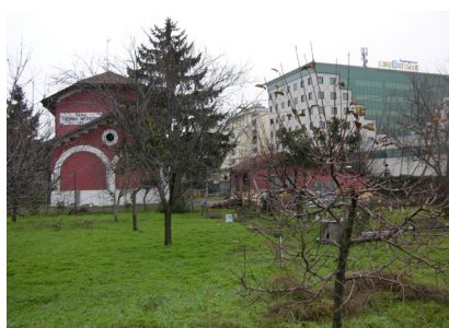
Vista della casa cantoniera a sud-ovest
