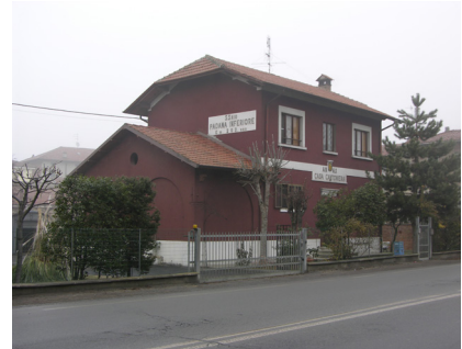
Casa cantoniera ex Anas sulla strada Padana Inferiore
