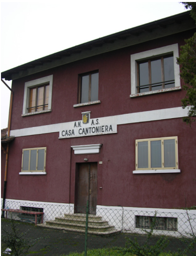
Ingresso sulla facciata principale a nord
