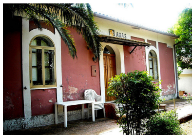
sp 162 km 14, località Cortale (Cz) - Calabria
