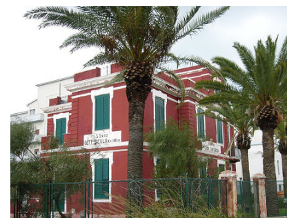
Casa cantoniera ex Anas sulla strada Settentrionale Sicula
