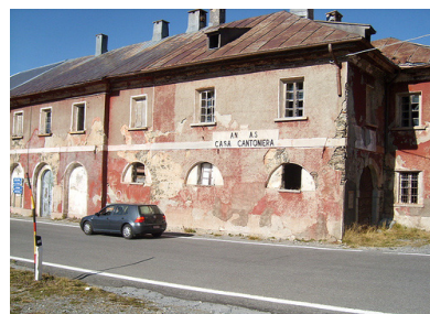
SS 38 Passo dello Stelvio - località Trafoi (Bz) - Trentino Alto Adige
