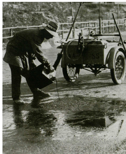
Spandimento di emulsione bituminosa
