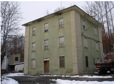
Vista complessiva dell'edificio
