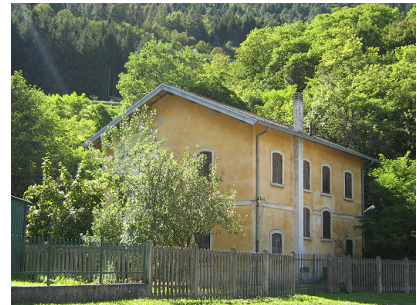
Casa cantoniera ferroviaria (ferrovia Belluno Cadore , Stazione di Ponte delle Alpi, 1938).
