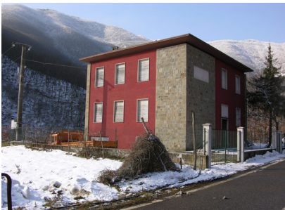
Vista della casa cantoniera dalla strada
