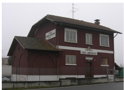
Vista della Casa Cantoniera dalla strada
