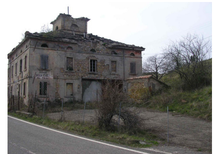
Casa cantoniera lungo la strada della Cisa
