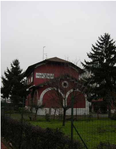
Vista della facciata a sud-ovest
