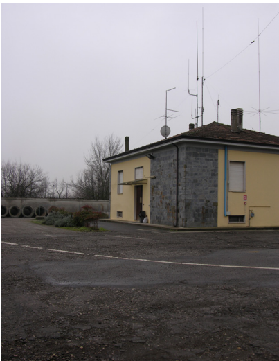
Vista della casa cantoniera dal piazzale
