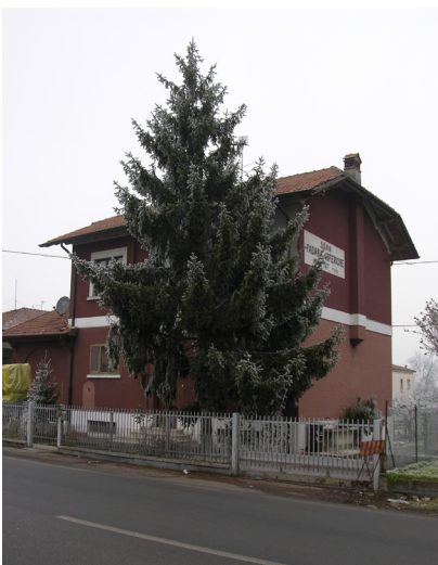
Vista della casa cantoniera dalla strada
