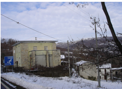
Veduta della casa cantoniera dalla strada
