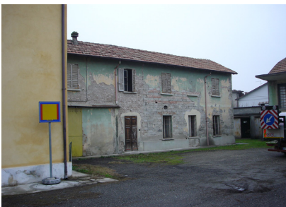
Edificio annesso alla casa cantoniera
