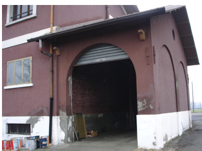
Magazzino annesso alla casa cantoniera
