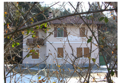
SS 49 Via Vecchia - Pusteria Sudtirolo (Bz) - Trentino Alto Adige
