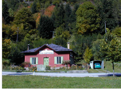
SS 42 del Tonale della Mendola localit  Commezzadura (Tr) - Trentino Alto Adige
