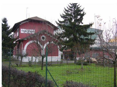
Vista della facciata a sud-ovest
