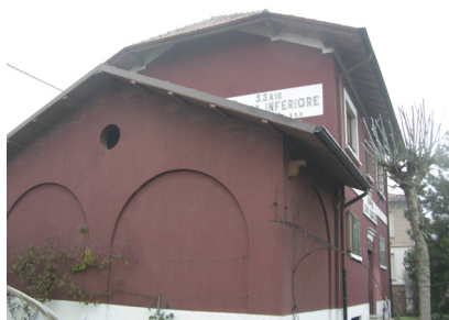
Vista della facciata a ovest
