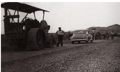
Lavori di manutenzione stradale
