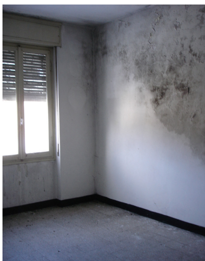
Vano al piano primo
