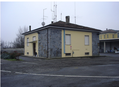
Vista della facciata a nord
