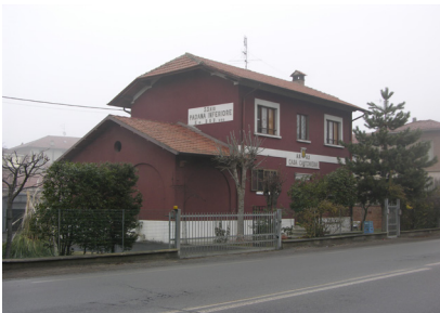
Vista della casa cantoniera dalla strada
