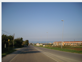
5) Tratto asse centrale di ingresso città
