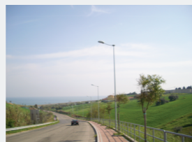
7) Tratto di strada di scorrimento secondaria
