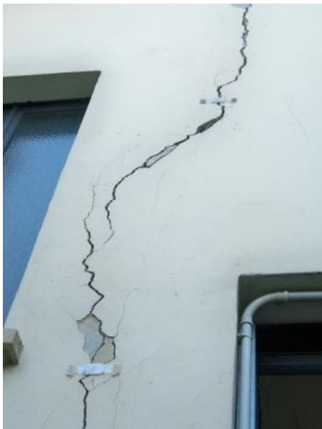
Figure 20 e 21 – Una grande fessura nella zona di contatto tra il corpo in posto ed il corpo che sta cedendo
