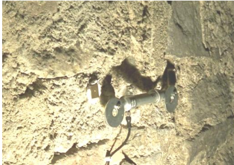
Figura 220 – Il trasduttore potenziometrico con aggiunte le rondelle e, appena sopra, le basette per la misurazione con il deformometro meccanico a base 250 mm sulla fessura S3
