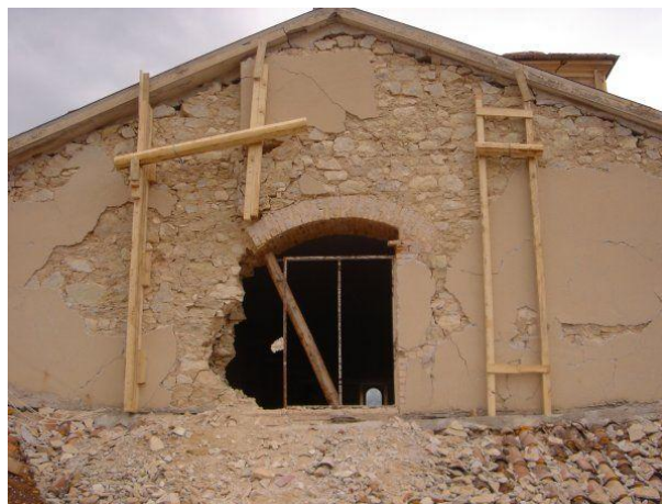
Figura 34 – Esempio di intervento repentino di messa in sicurezza
