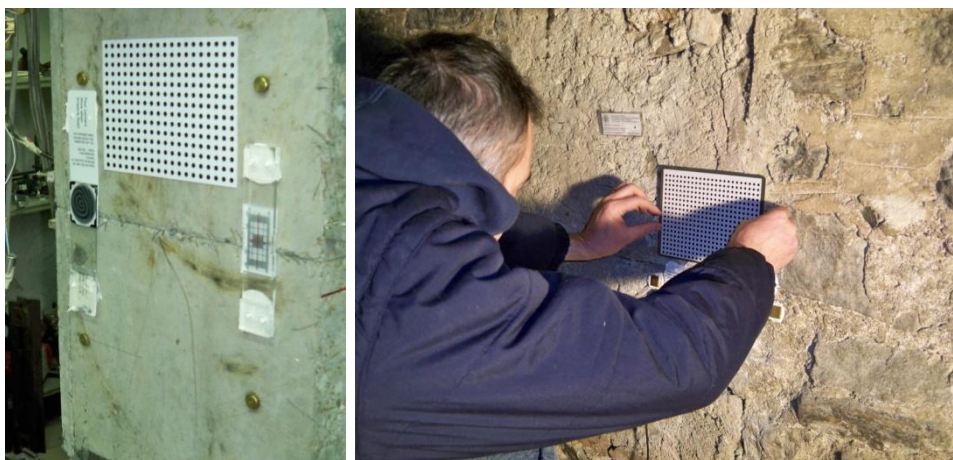
Figure 127 e 128 – A sinistra la griglia di riferimento direttamente incollata sulla superficie; a destra invece preventivamente incollata su di un supporto metallico a sua volta fissato sulla muratura
