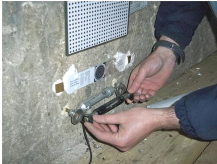
Figura 240 – Verifica e correzione della posizione delle rondelle con una dima
