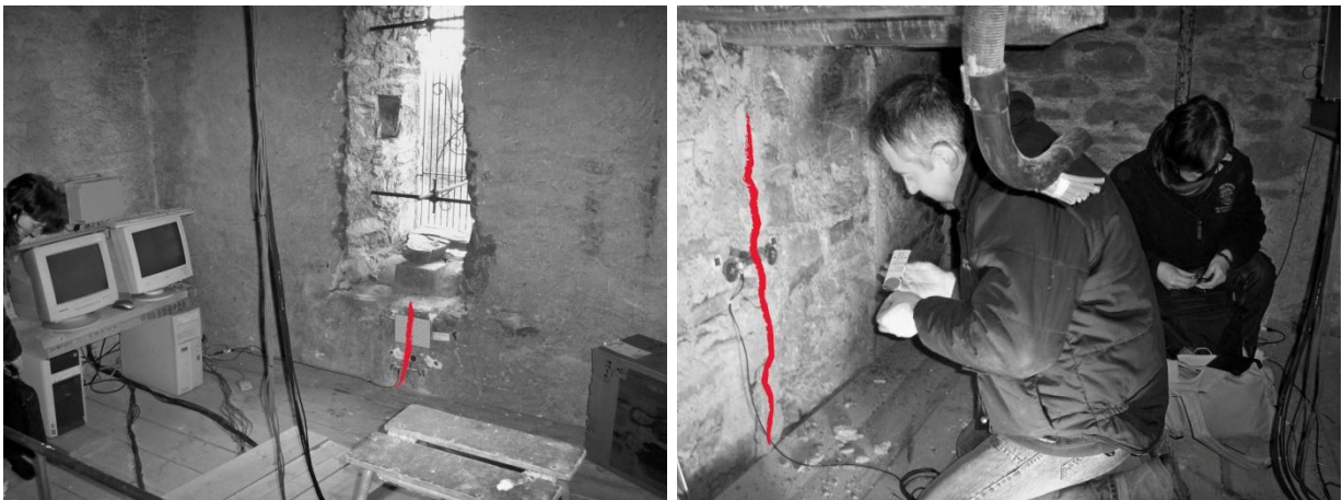
Figure 218 e 219 – La fessura S2 al quarto livello e la fessura S3 al quinto livello evidenziate da un colore rosso
