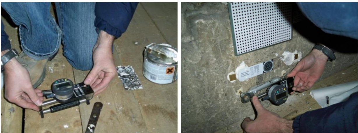
Figure 241 e 242 – Taratura del deformometro meccanico a base 140 mm e prima misurazione di prova
