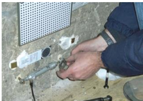
Figura 239 – Il fissaggio della prima rondella sull'estremità destra del trasduttore potenziometrico
