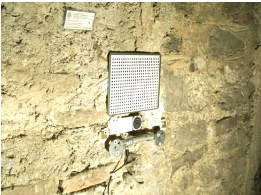
Figura 231 – La fessura S3 una volta ultimate le operazioni di fissaggio di tutti gli strumenti
