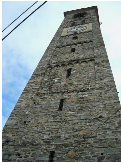
Figura 214 – La torre campanaria di S. Vittore ad Arcisate. Si noti la disomogeneità del suo tessuto murario
