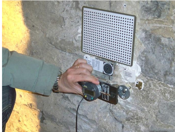
Figura 255 – Il deformometro Controls a base 140 mm sulla fessura S3. La lettura viene eseguita sulle bollinature fatte sulle rondelle fissate agli estremi del trasduttore potenziometrico
