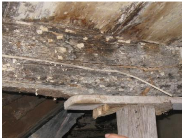
Figura 28 – Una trave in legno inflessa e fessurata. E' stata posta una stampella di appoggio poco prima del suo molto probabile collasso
