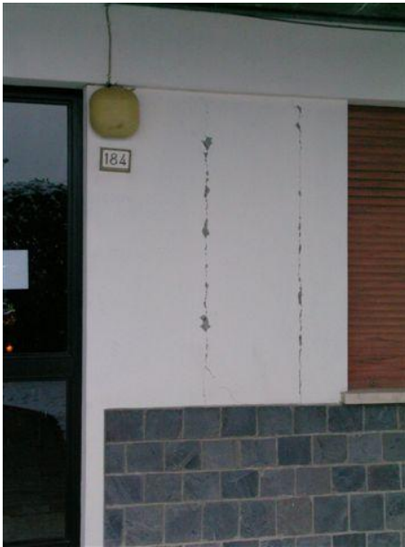
Figure 18 e 19 – Fenomeni di fessurazione verticale del solo strato di intonaco in corrispondenza di un pilastro
