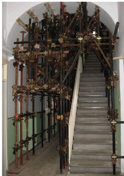
Figura 35 – Esempio di intervento preliminare di messa in sicurezza di un edificio pericolante
