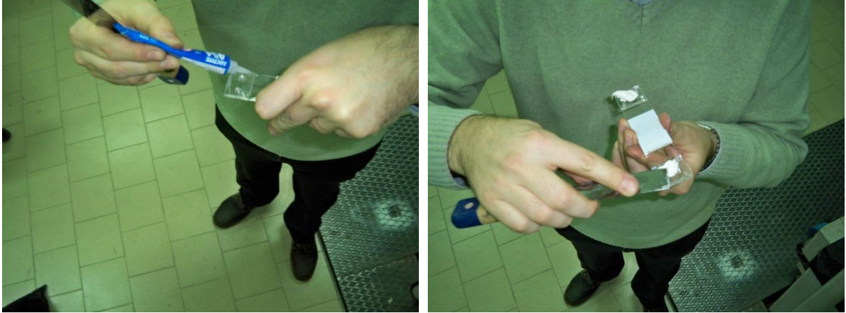
Figure 182 e 183 – Applicazione della colla a presa rapida e del mastice solido sul fessurimetro piano
