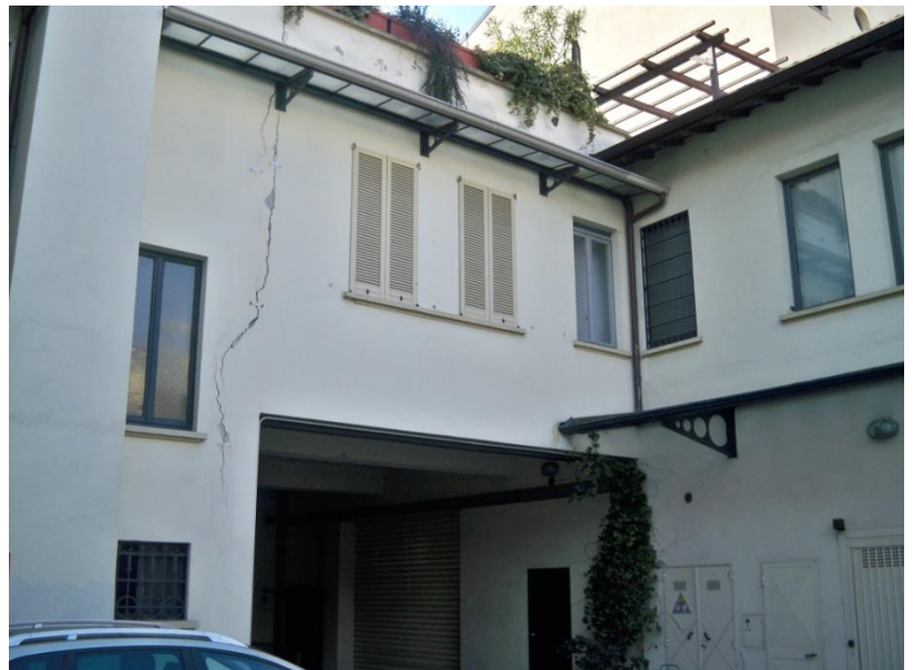
Figure 20 e 21 – Una grande fessura nella zona di contatto tra il corpo in posto ed il corpo che sta cedendo
