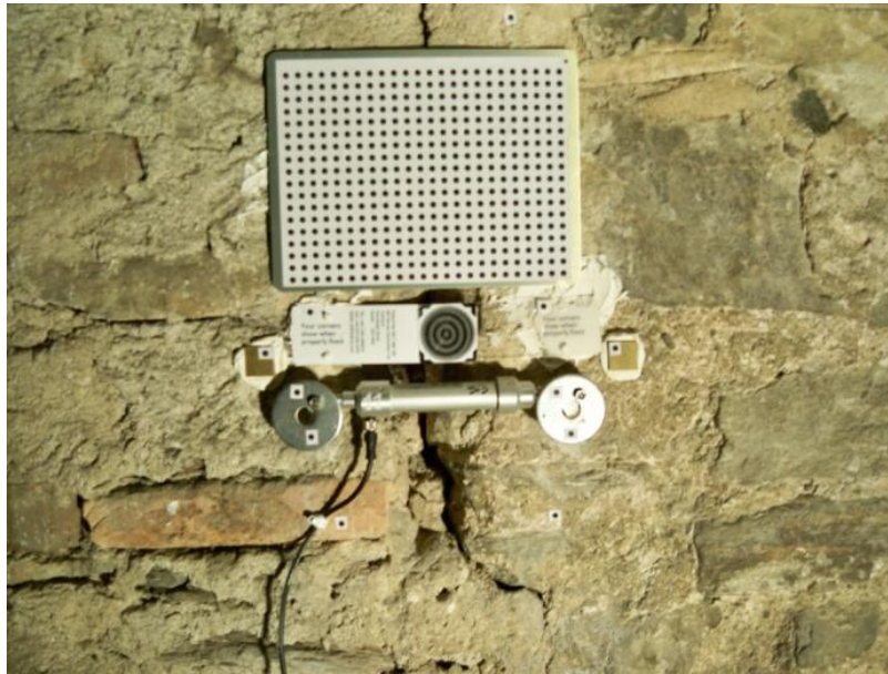
Figura 248 – Tutti gli strumenti applicati sulla fessura S3
