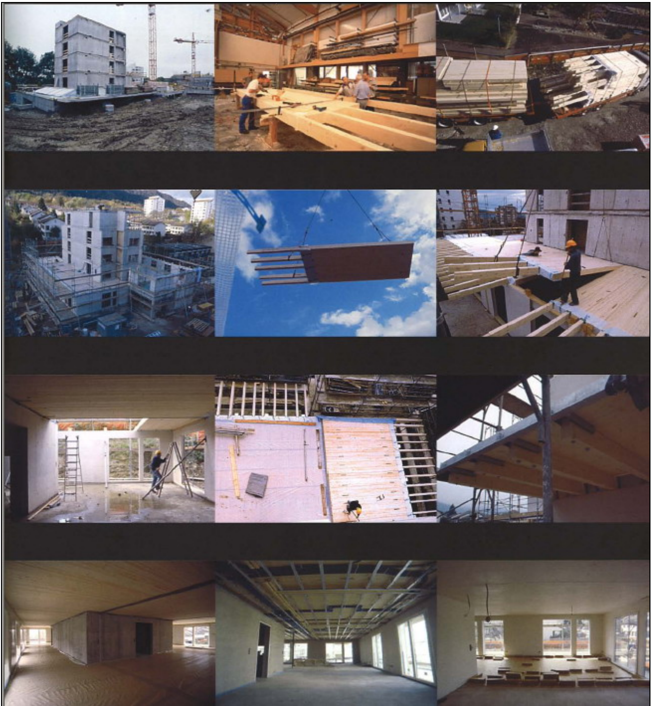
Figura 26: EM2N_Hegianwandweg housing, fasi di costruzione
