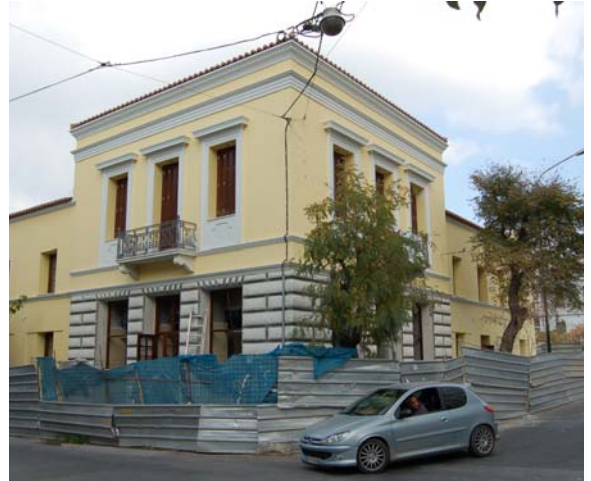
Figura 23: Il restauro della vecchia seteria (ospiterà la nuova pinacoteca comunale)
