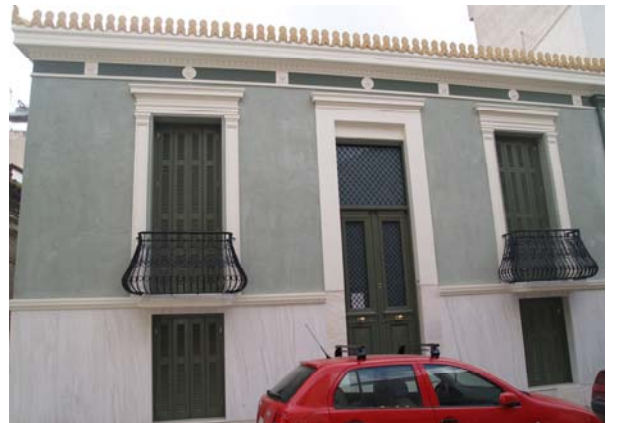
Figura 18: Villetta recentemente restaurata
