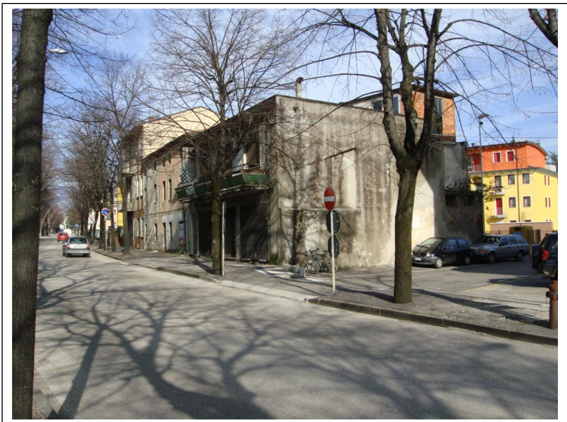
Come sopra, edifici in stato di abbandono e degrado.
