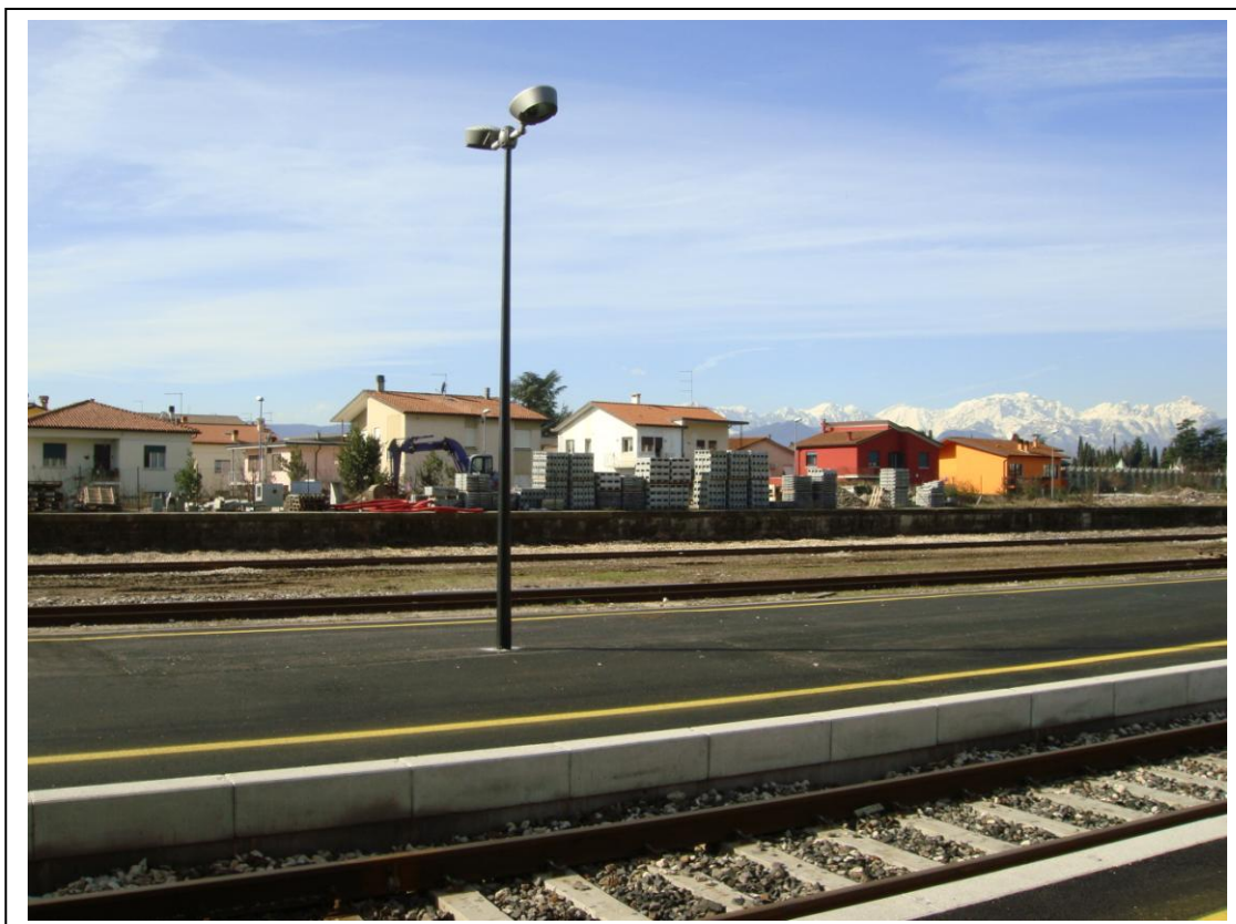
Il quartiere residenziale a quota -330cm rispetto alle banchine e separato dalla città dai binari. Vista dalla stazione ferroviaria.
