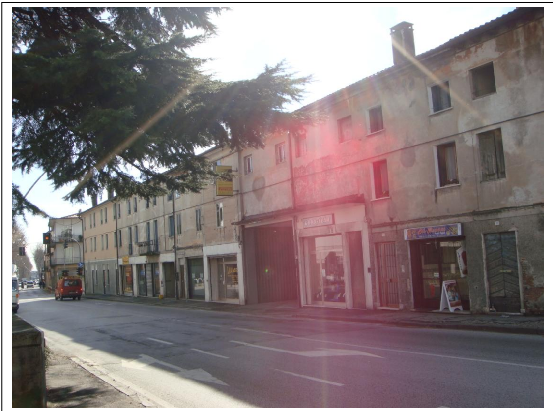
Alcuni edifici in stato di degrado che affacciano sulla circonvallazione.
