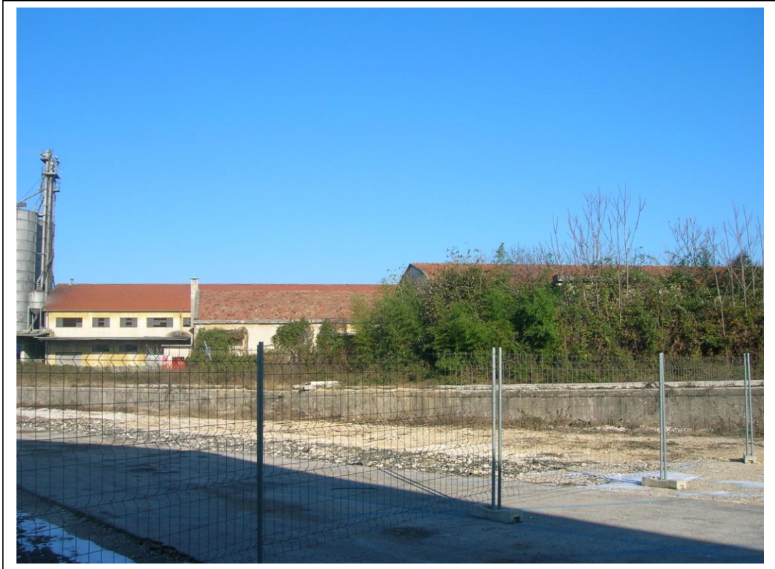
I tre magazzini del Consorzio agrario di differenti dimensioni. Il blocco maggiore con una superficie pari a 1920mq disposti su due piani, l'intermedio con superficie pari a 630mq e il minore con una superficie di 385mq.
