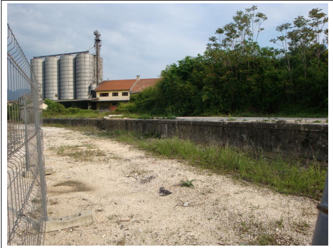
L'area dello scalo ferroviario oggi in disuso. In primo piano i terrapieni per il carico e lo scarico delle merci. Sullo sfondo i magazzini del vecchio Consorzio agrario e i silos annessi.
