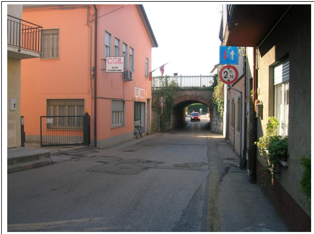
Il sottopassaggio che collega la parte nord della città con il quartiere residenziale a sud. Il sottopassaggio è ad un'unica corsia a senso alternato ed è completamente privo di marciapiede.
