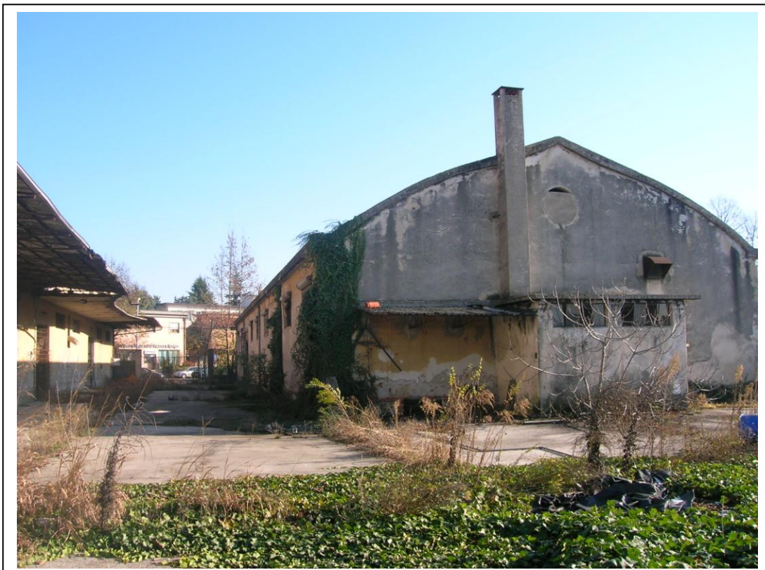
Vista interna dall'area dell'ex Consorzio Agrario. In evidenza la struttura a volta a botte tipica della zona.
