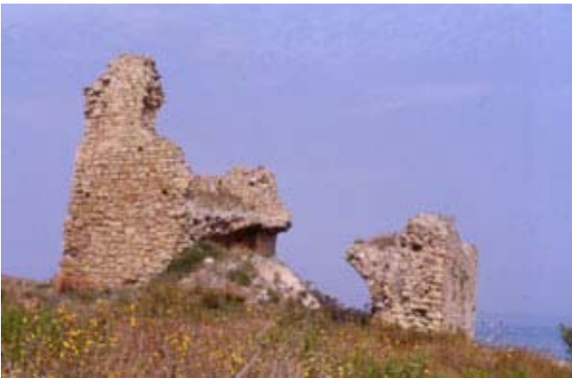
Fig. 3.32 Torre di avvistamento
