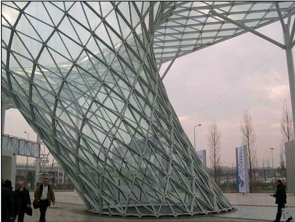
Particolare della copertura della nuova fiera di Milano, arch. Massimiliano Fuxas
