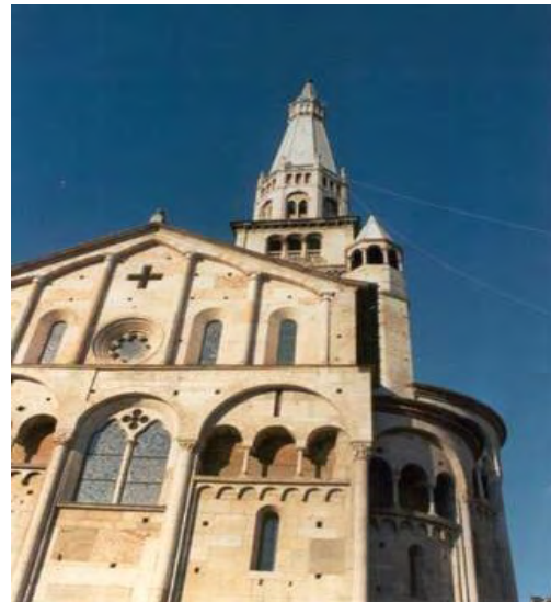
Rivestimento in pietra del Duomo di Modena
