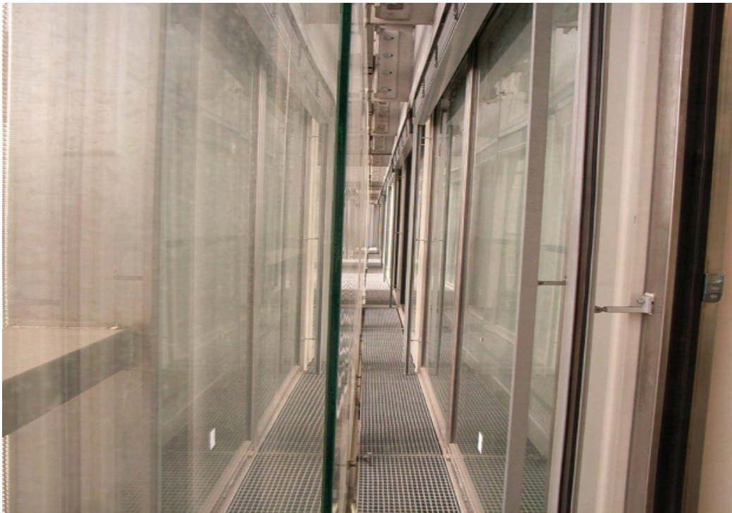
Particolari di involucro a doppia pelle vetrata
