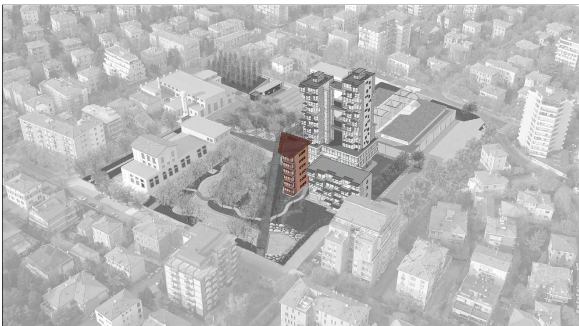
Navigator, l'edificio per uffici
