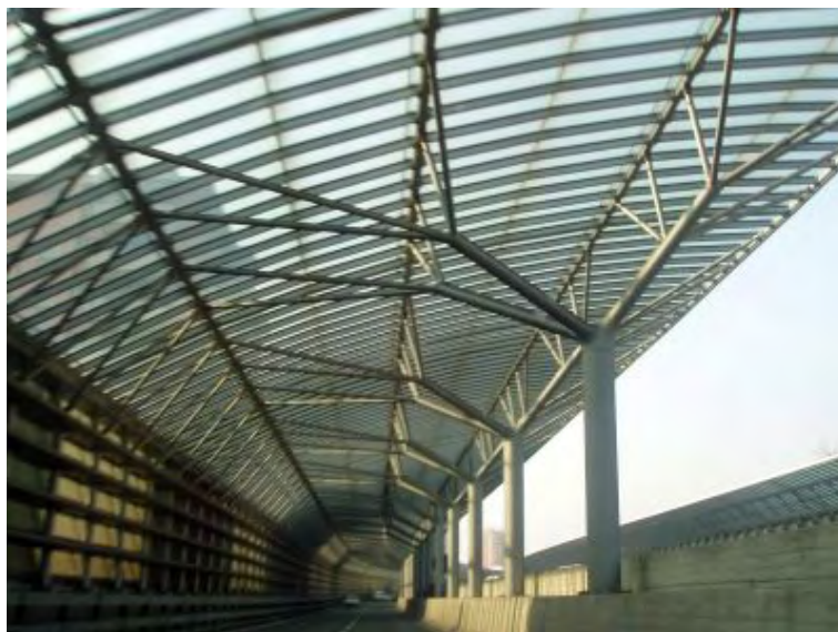
Barriera antirumore, Chiasso, Arch. Mario Botta
