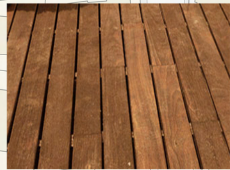
Pavimentazione in legno
