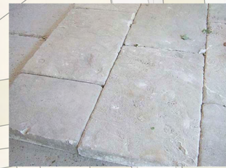
Pavimentazione di pietra in lastre
