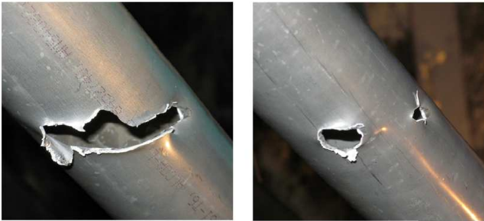
Figura 1.6: Esempio di foro singolo e doppio riscontrati da Giudici [7]
