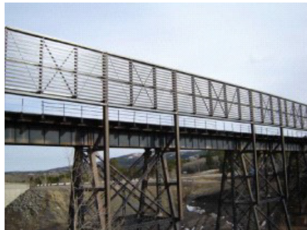
Figura 1.9 - Barriere antivento del viadotto di Midwale Creek (Montana, USA).
