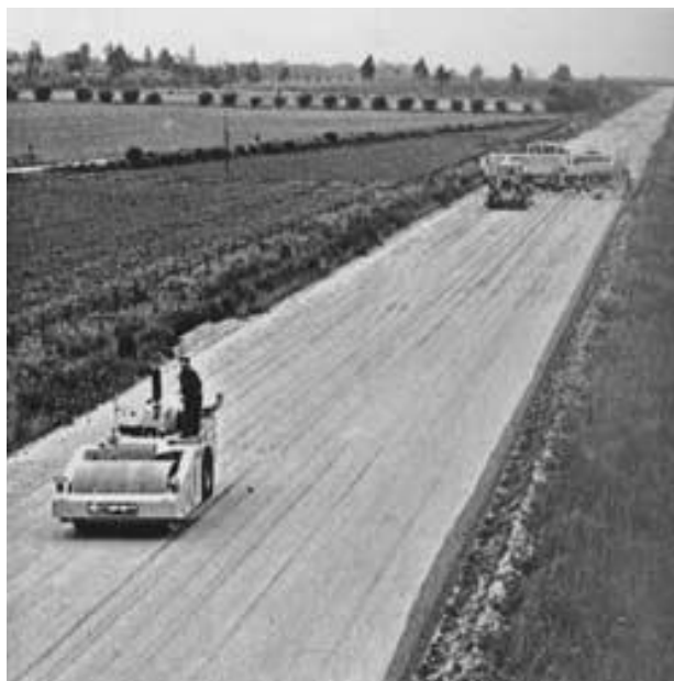
Figura 1 Realizzazione di un tratto dell'autostrada A21 anni '60
