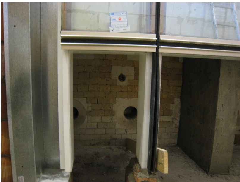
Figura IV-25 Particolare dell'interno del forno – colonna di sostegno centrale
