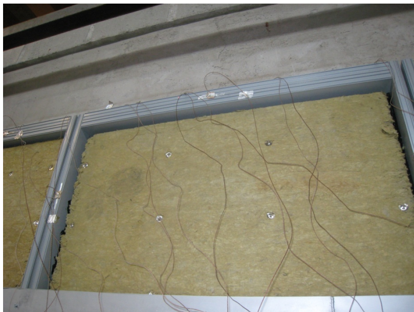
Figura IV-8 Particolare dell'isolamento in lana di roccia esterno
