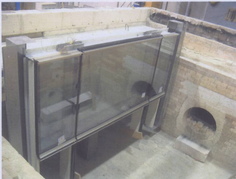
Fotografia della superficie esposta al fuoco della facciata durante la fase di allestimento.
