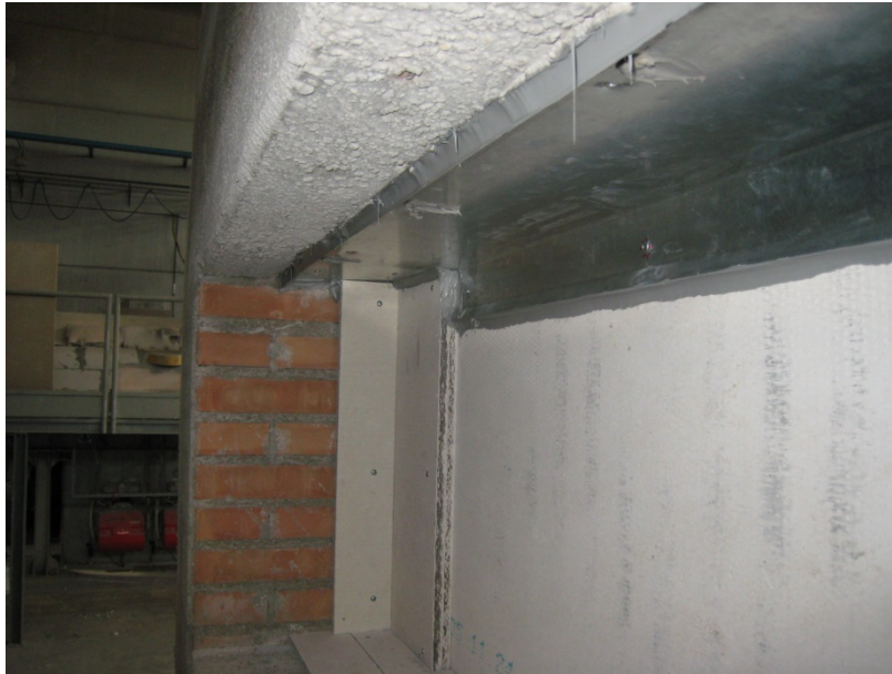
Figura IV-9 Particolare del campione innestato sulla struttura di sostegno
