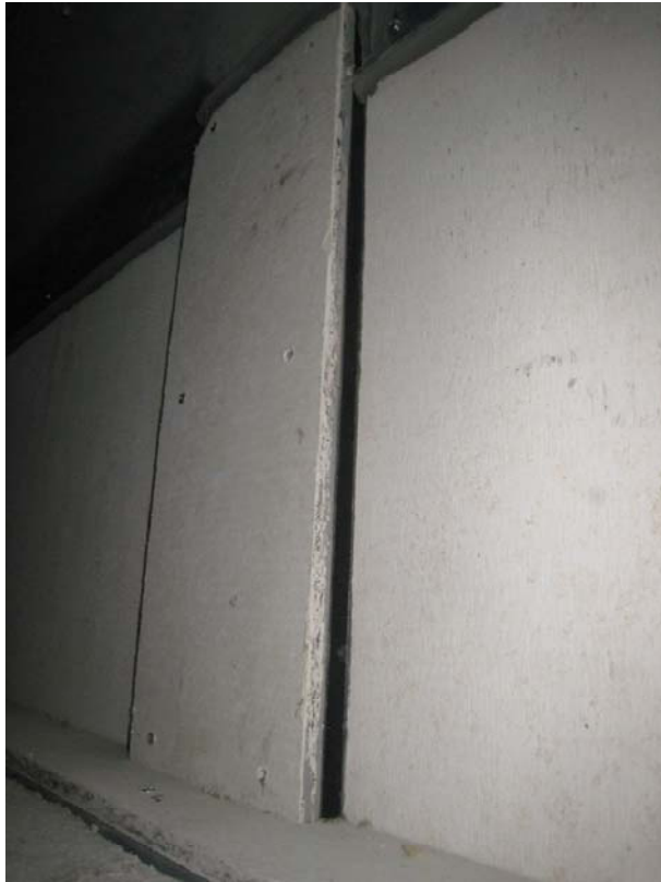
Figura IV-7 Particolare lastre di fibrosilicato, lato esposto
