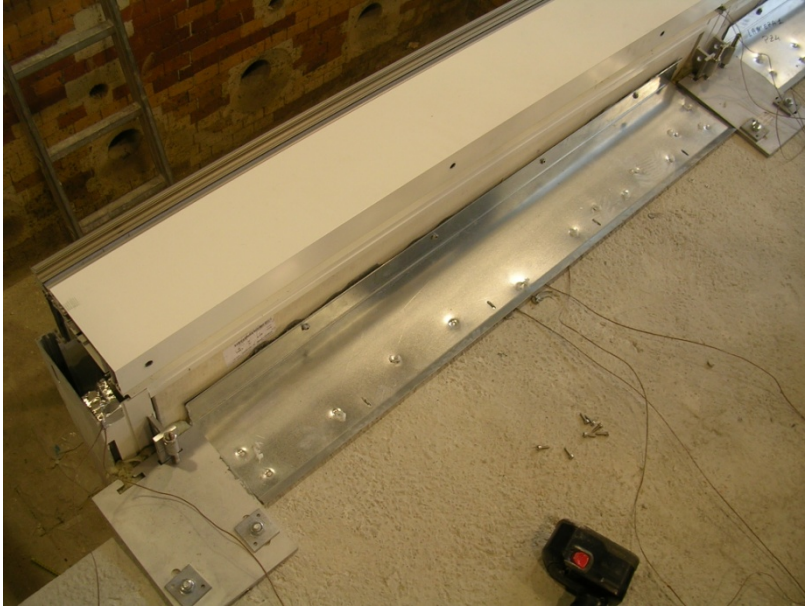
Figura IV-19 Particolare delle staffe di aggancio
