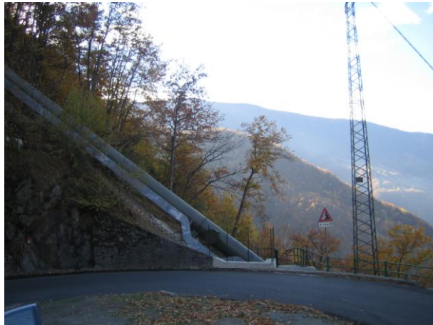
Figura n°26: Condotta forzata della Val Tartano
