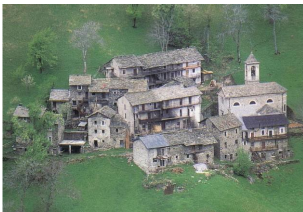
Figura n°71: Vista di Sostila
