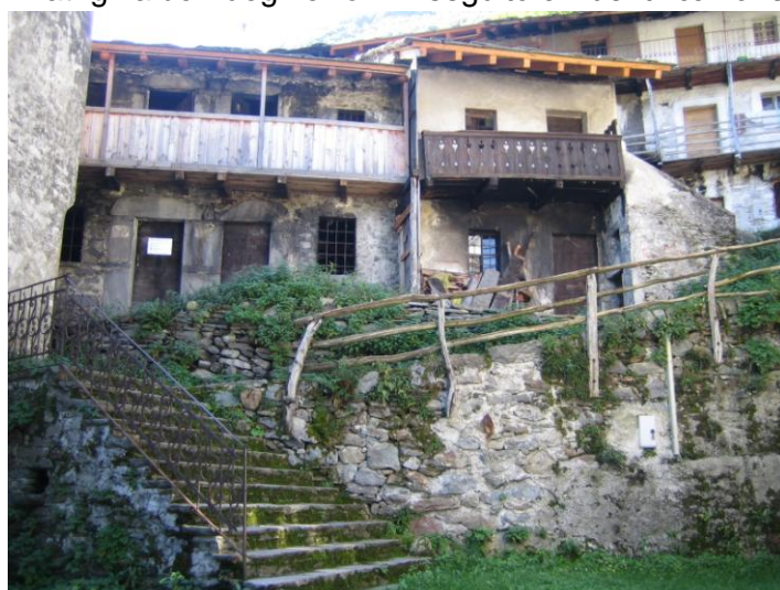
Figura n°204: Prospetto Nord degli edifici
