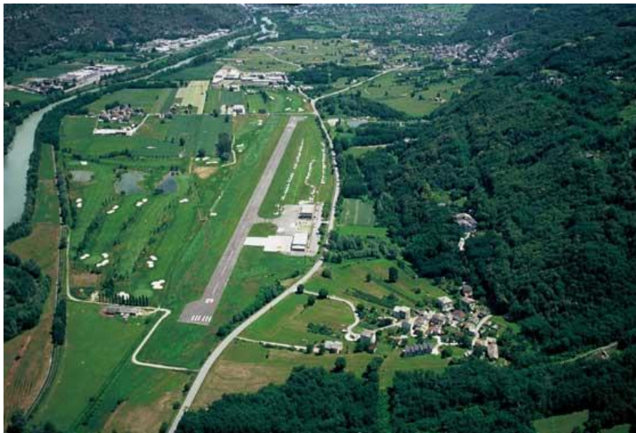
Figura n°13: Vista aerea dell'eliporto di Caiolo in Alta Valtellina
