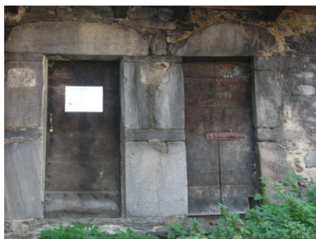
Figura n°124: Esempio di porte gémine
