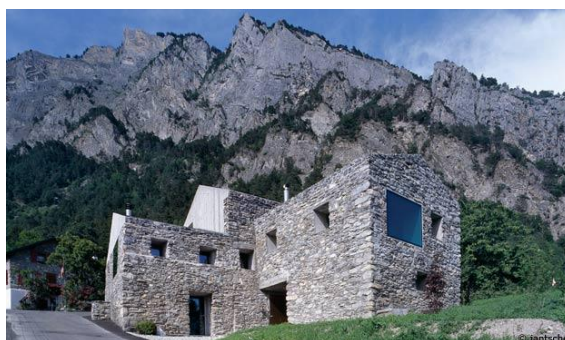
Figura n°196: Vista esterna dell'edificio
