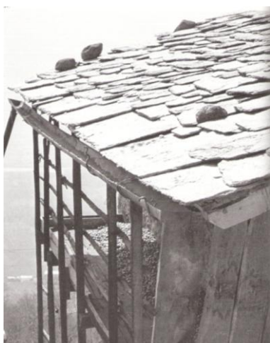
Figura n°35: Rustico a Pianezzo, particolare del tetto in pietra
