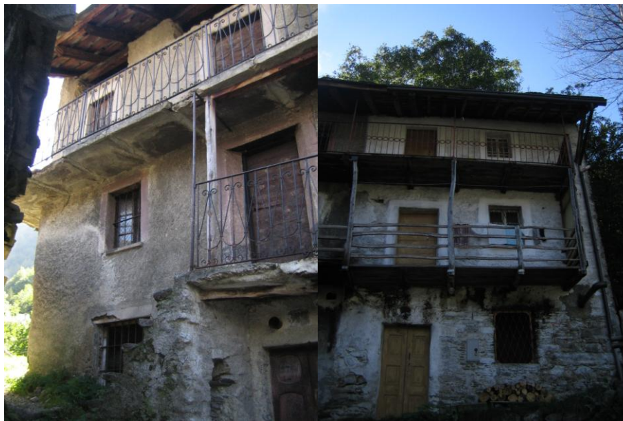
Figura n°186: Prospetto Nord degli edifici 90-91-92-93-94
