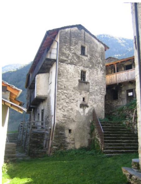
Figura n°123: Casa su quattro piani affacciata sulla piazza
