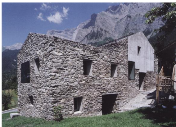
Figura n°192: Vista generale dell'edificio
