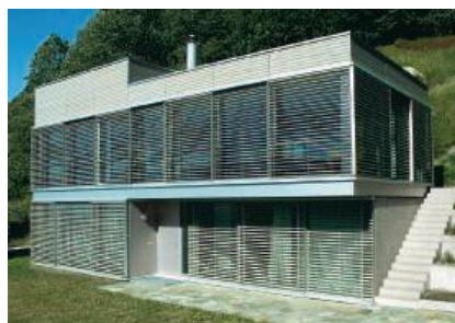
Figura n°180: Vista generale del nuovo edificio
