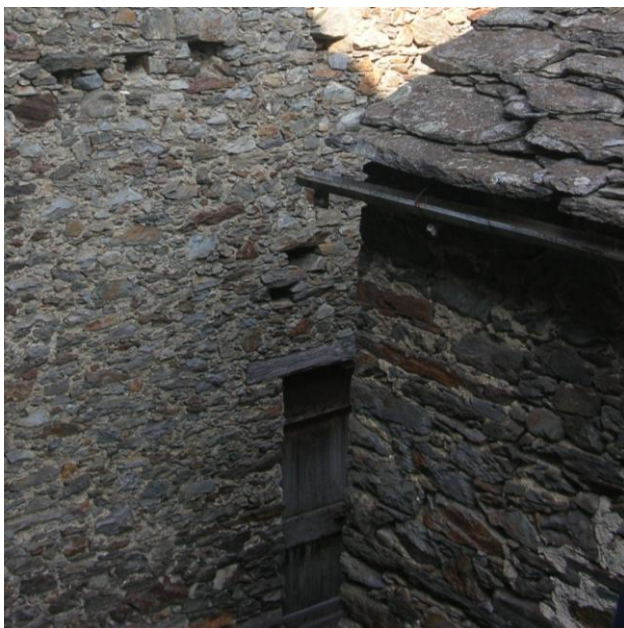
Figura n°212: Esempio muratura esistente
