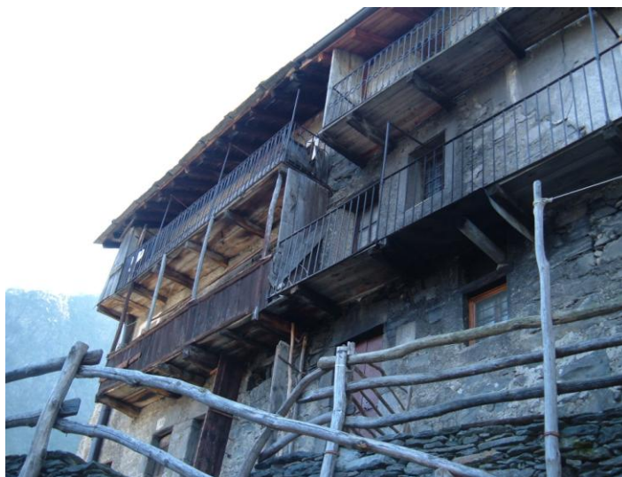
Figura n°210: Prospetto Nord degli edifici
