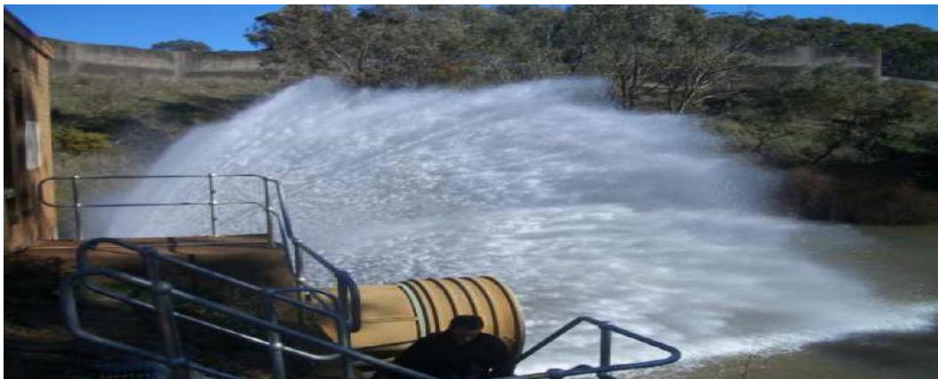
Figura 1.4: Chiusa con attuatore a cono
