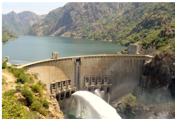
Figura 4.7 – La Diga di Cahora (fonte citata)
