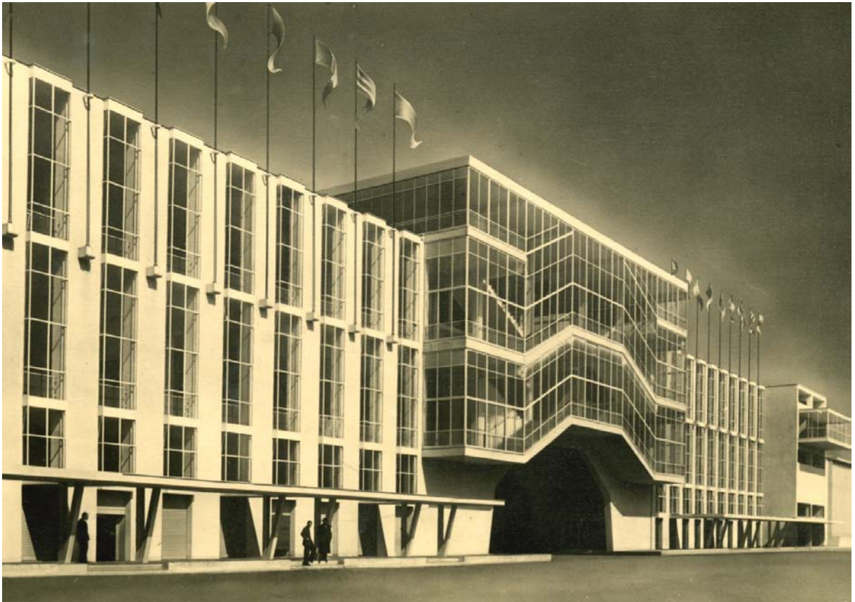
36. Palazzo delle Nazioni, Fiera Campionaria di Milano, 1937. Fonte: Archivio Storico Fondazione Fiera.
