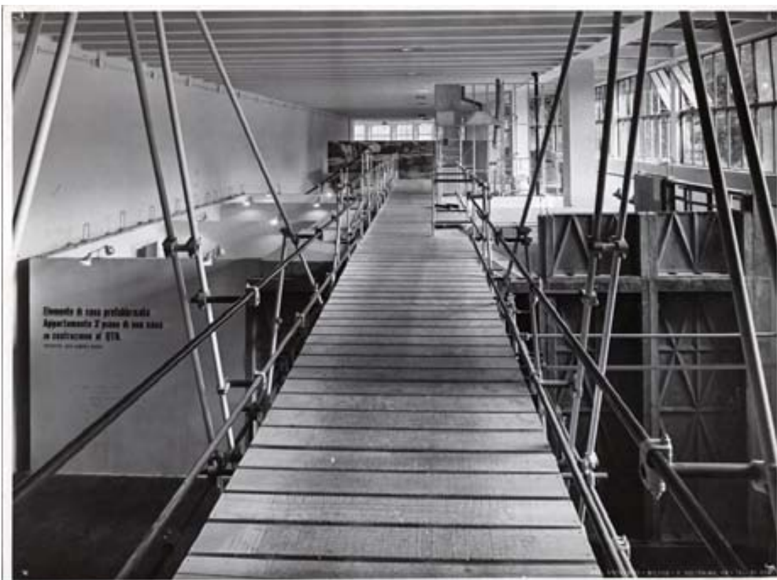
14-15. (sopra) Dettaglio dei tubi d'acciaio che sostengono la passerella. (sotto) Vista dall'alto della passerella che sormonta le sale espositive a piano terreno, VIII Triennale, Milano 1947. Fonte: Archivio storico Triennale.
