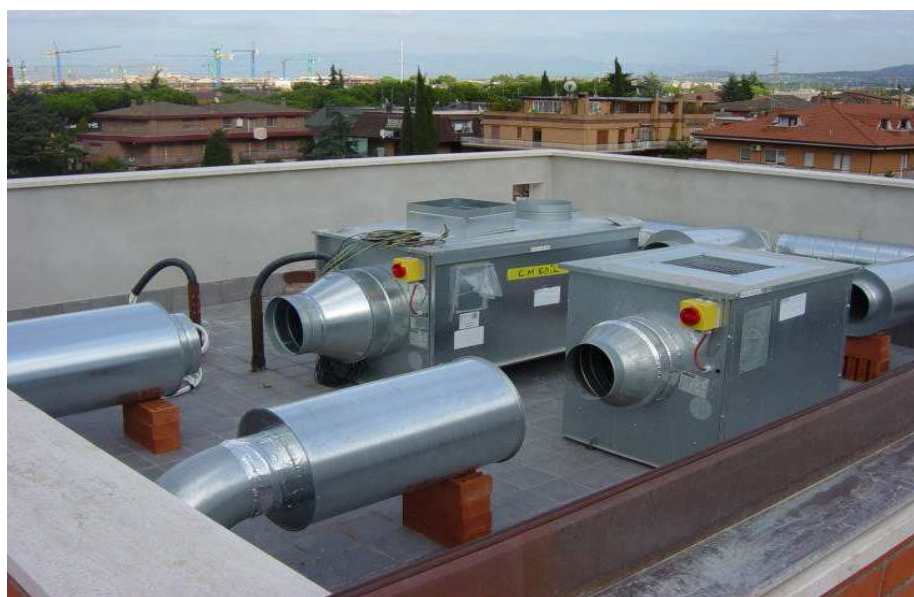
FIG.48 Esempio di ventilazione centralizzata ( vista in copertura)
