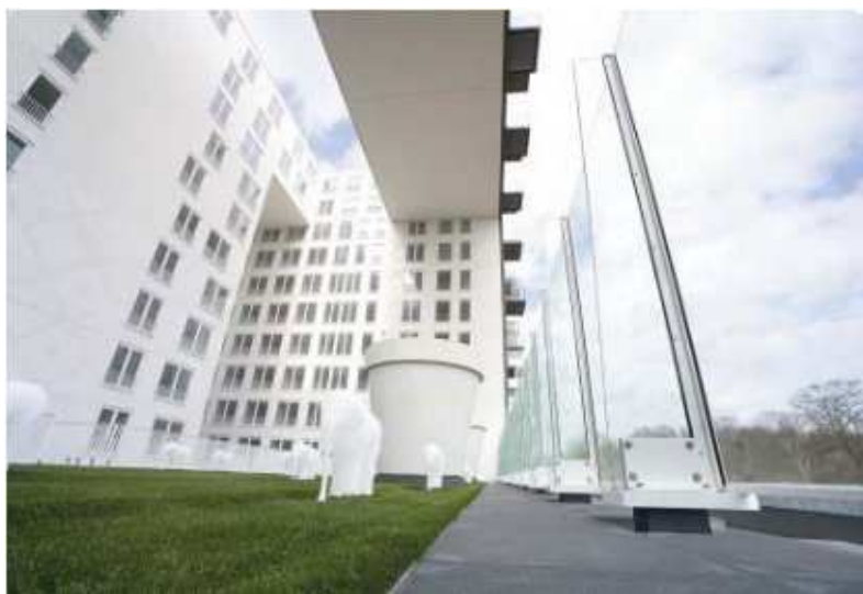
FIG.6 Particolare di una delle torri del complesso edilizio
