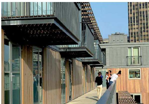
FIG.9 I ballatoi dell'edificio sono spazi utilizzati dalla collettività.
