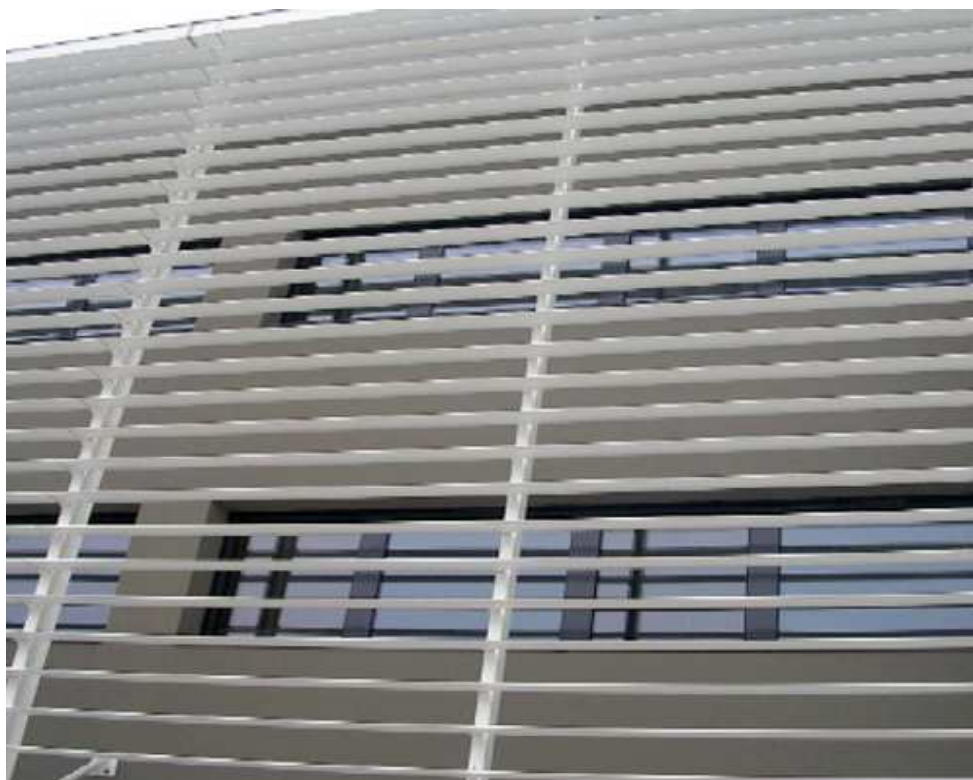
FIG.45 Esempio di frangisole realizzato in alluminio
