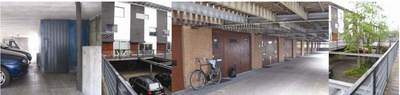
Fig. 72 - Posti auto e cantine del villaggio Matteotti a confronto con quelle del Nieuw Terbregge (Mecanoo, Rotterdam, Paesi bassi, 2001) anch'essi ricavati al piano terra sotto uno spazio pubblico a quota rialzata, risolti architettonicamente in modo di rendere lo spazio ampio e luminoso.
