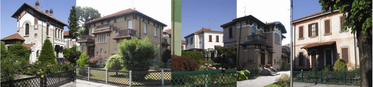
Fig. 9 - Ville per impiegati e case per operai del villaggio Crespi d’Adda, provincia di Bergamo.
