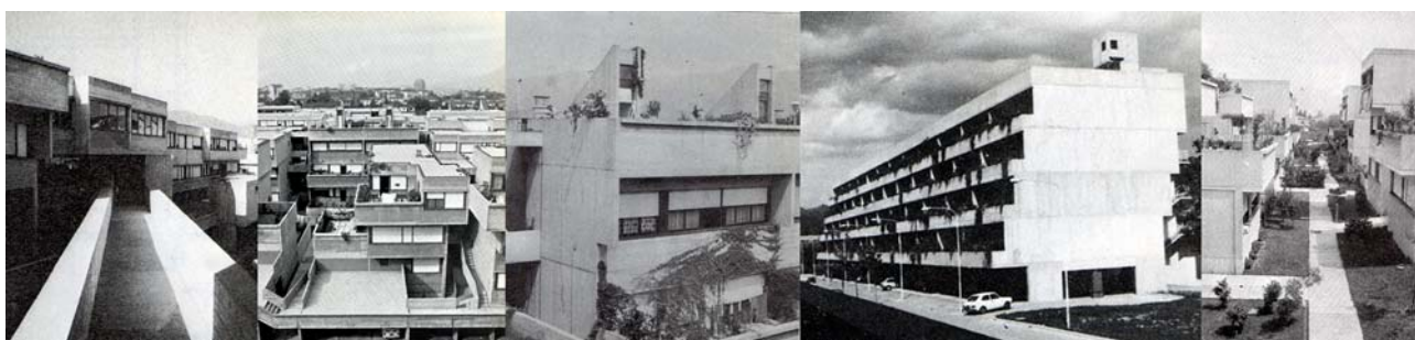
Fig. 30 - Immagini del nuovo villaggio Matteotti negli anni Settanta: i percorsi pensili trasversali che collegano i servizi, veduta aerea, dettaglio del fronte sui percorsi alberati, l'edificio di appartamenti, un o dei percorsi alberati negli anni Settanta.
