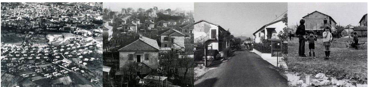
Fig. 24 - Il villaggio Matteotti prima dell’intervento di ristrutturazione.
