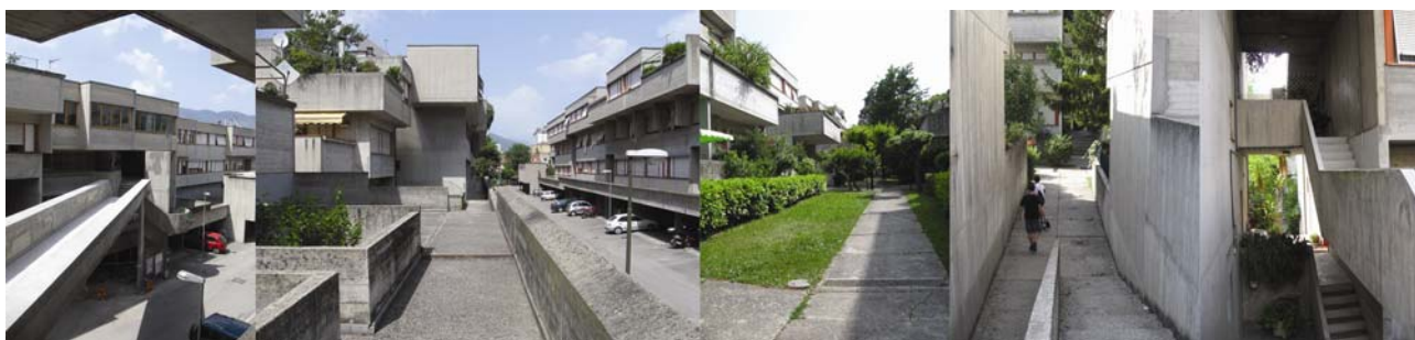
Fig. 62 - Schema della gerarchia dei percorsi pedonali e immagini illustrative: i percorsi trasversali che collegano le attrezzature collettive, i percorsi pensili paralleli alle strade, i percorsi alberati a carattere semipubblico, i passaggi di collegamento tra i blocchi edilizi e i blocchi scala.
