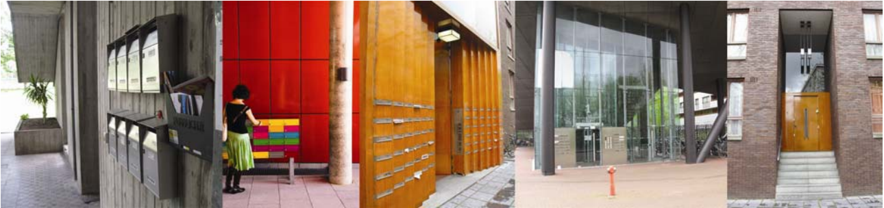
Fig. 79 - Un ingresso del villaggio Matteotti e gli ingressi di interventi contemporanei di housing sociale: Adelaide Wharf a Londra (Allford Hall Monaghan Morris, 2008) , Piraeus ad Amsterdam ( Hans Kollhoff, Rapp + Rapp, 1998) , The Whale ad Amsterdam (Arkitekten Cie, 1995-2000) e un'altra immagine di Piraeus.
