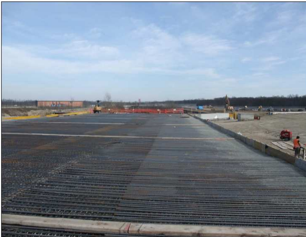
Figura 1.12: Armatura della soletta del ponte ovest di Malpensa
