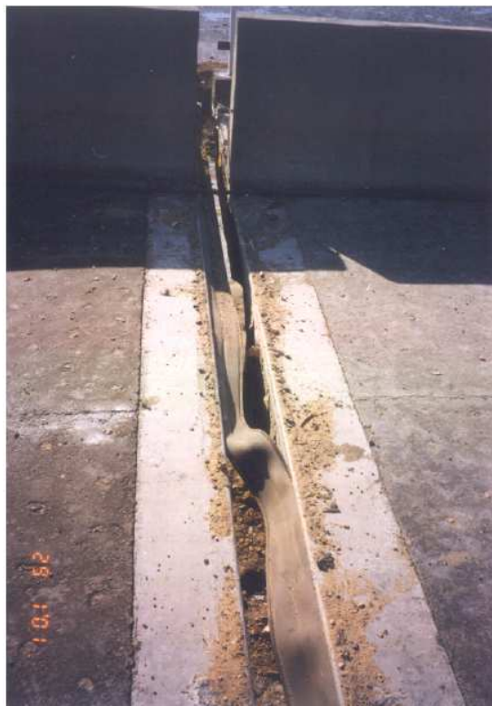
Figura 1.4: Rottura del dispositivo di giunto (Tandon, 2005)
