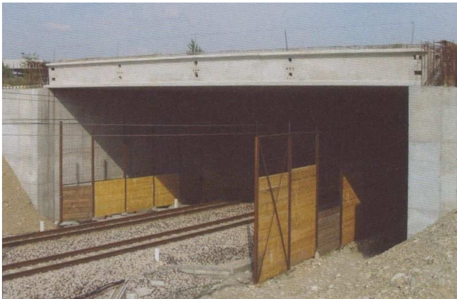
Figura 7.26: Impalcato con traversi (Comaita, Malerba, Paracchini, 2008)
