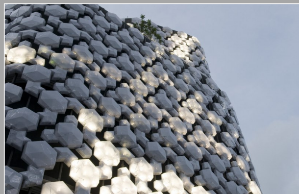
dettaglio dell'involucro architettonico
