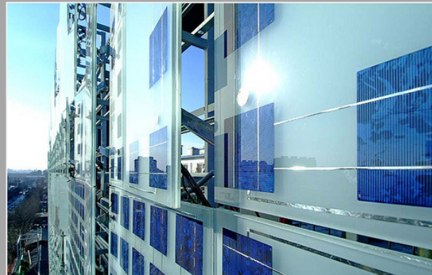
dettaglio dei moduli del rivestimento esterno
