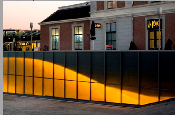
dettaglio dell'involucro architettonico
