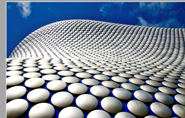
dettaglio dell'involucro architettonico
