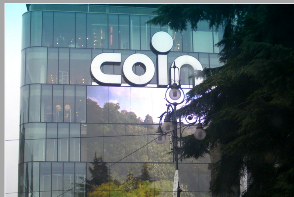
vista della facciata mediatica dalla piazza
