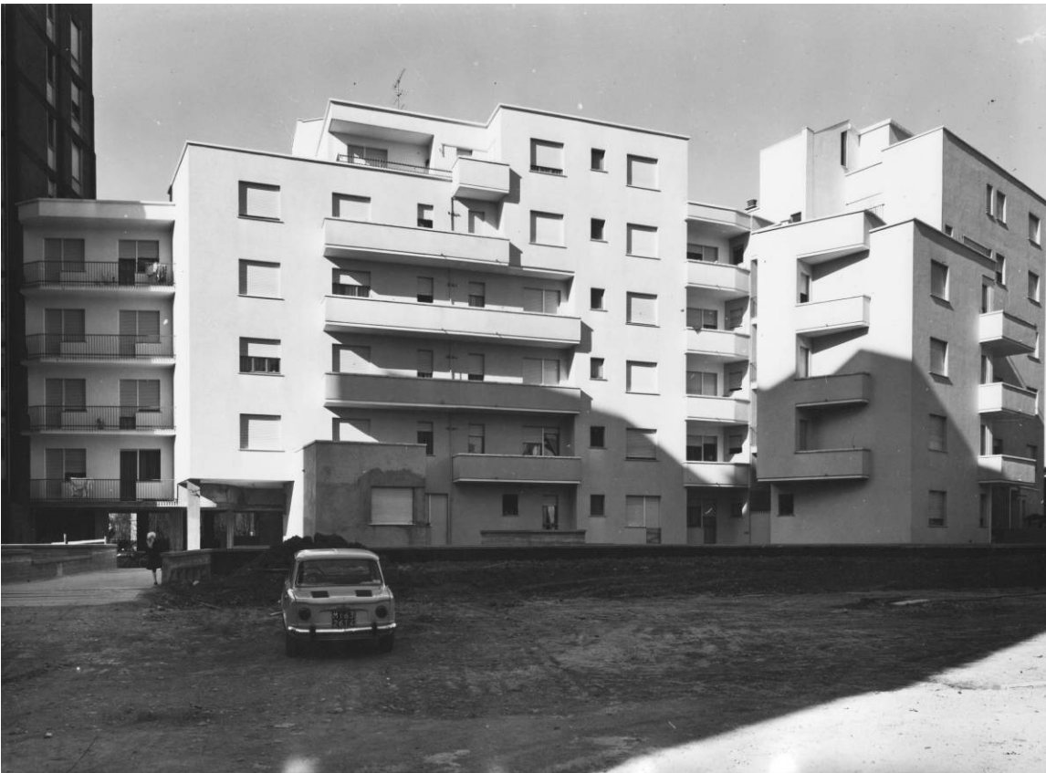
Fig.61. Case d'abitazioni per la Cooperativa Edificatrice Bollatese. s.d. Bollate. Fotografia dall'interno del complesso in fase di costruzione.
