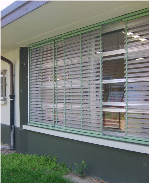
Fig.106. Scuola elementare. 1968-74, Rozzano, via Ugo Foscolo. Fotografia di un dettaglio delle schermature scorrevoli.
