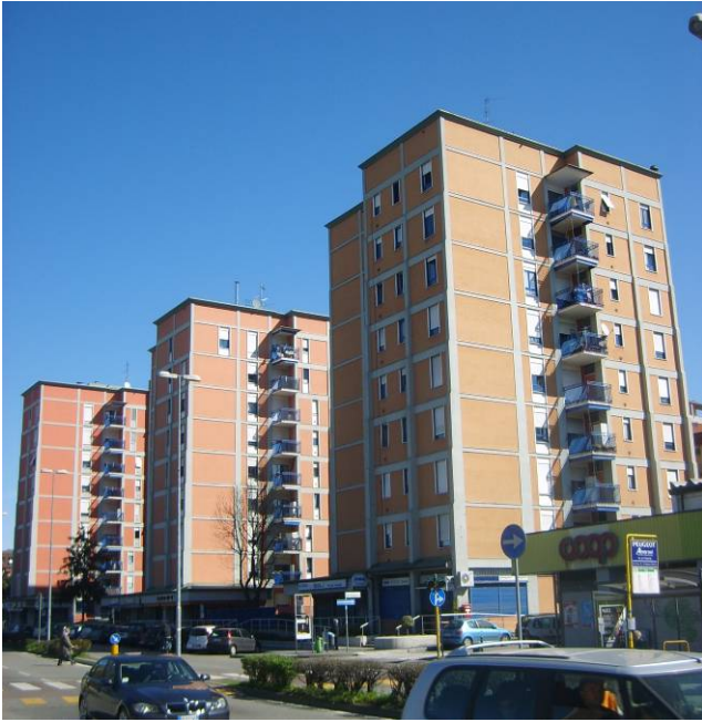
Fig. 57. Case d'abitazioni per la Cooperativa Edificatrice Bollatese. 1961-63. Bollate. Fotografia da via Vittorio Veneto
