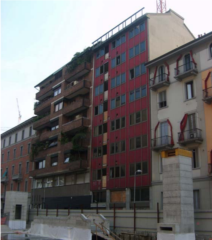
Fig.14. Novella Sansoni, Edificio per abitazioni, Milano, via Volturno 31. Alessandro Tutino, Sede della Federazione Comunista, via Volturno 33. Fotografia dello stato attuale.
