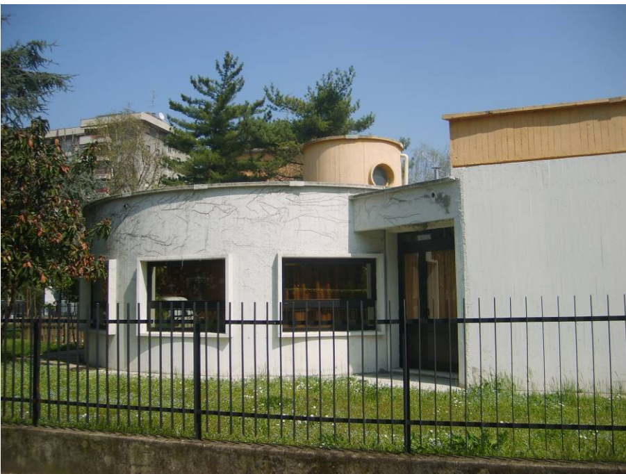
Fig.121. Asilo di Cinisello Balsamo. Fotografia esterna di un aula.
