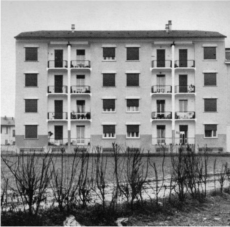
Fig.29. Casa d'abitazione per la Cooperativa Edificatrice Patria e Lavoro. 1958, Cascine Olona, via Cavalletti. Fotografia.
