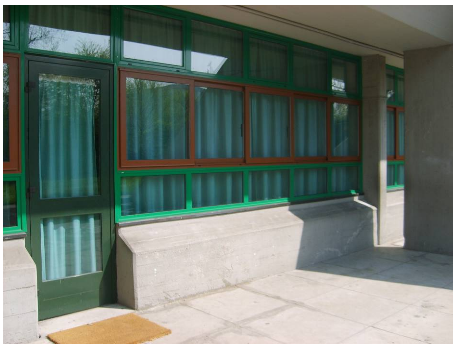
Fig.97. Scuola elementare. 1968, Cinisello Balsamo, via Abramo Lincoln. Fotografia dello spazio esterno di un'aula.
