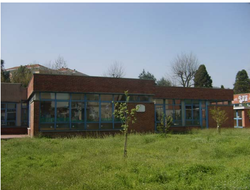
Fig.78. Scuola materna elementare. 1963-66, Rozzano,via Mincio. Fotografia della scuola materna.
