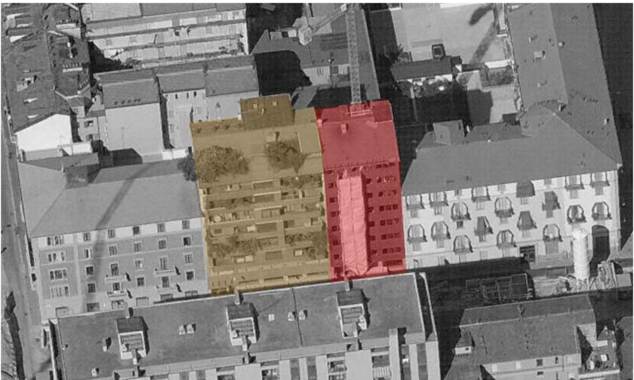
Fig.13. Novella Sansoni, Edificio per abitazioni, Milano, via Volturno 31. Alessandro Tutino, Sede della Federazione Comunista, via Volturno 33. Fotografia aerea.
