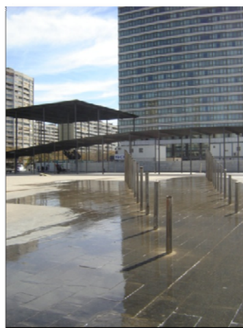
Figura 4.8 – Esempio di pavimento raffreddato con getti d'acqua. Piazzale della stazione di Barcellona Sants.
