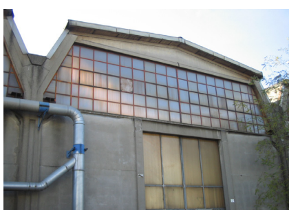
Fig.78 Foto del Villaggio Artigiano oggi
