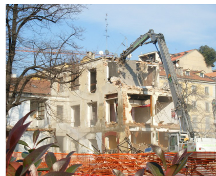
Fig.9 Fase di demolizione della Stecca degli Artigiani
