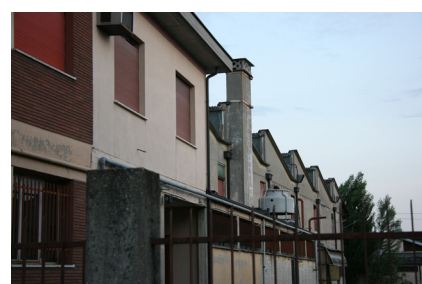
Fig.79 Foto del Villaggio Artigiano oggi
