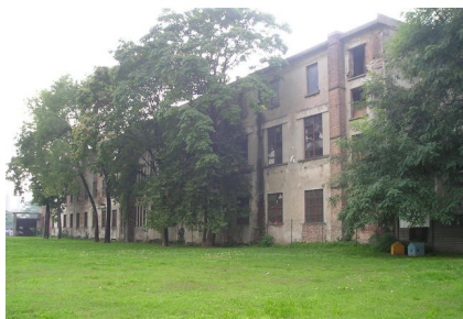
Fig.2 La stecca degli artigiani prima della demolizione
