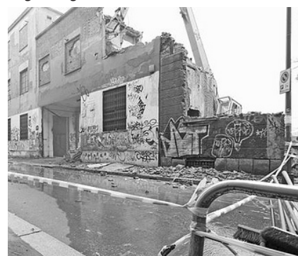
Fig.10 Fase di demolizione della Stecca degli Artigiani
