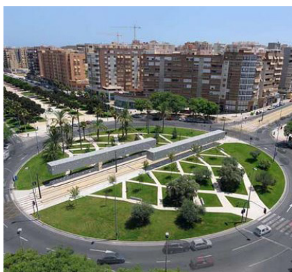
Fig.101 Rotonda di raccordo per percorso stradale con al centro fermata doppia tram e parco (Spagna)
