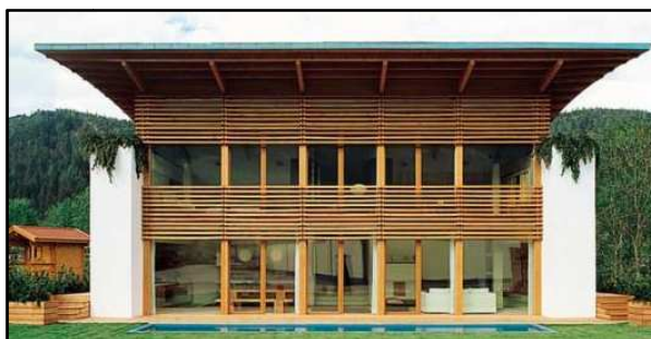
Figura 3. Esempio di casa solare, Matteo Thun per Rubner, Casa Heidis
