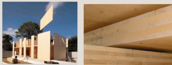
Panelli Klh _cantiere e immagazzinamento
