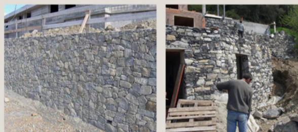
Rivestimento in pietra ligure _cantiere
