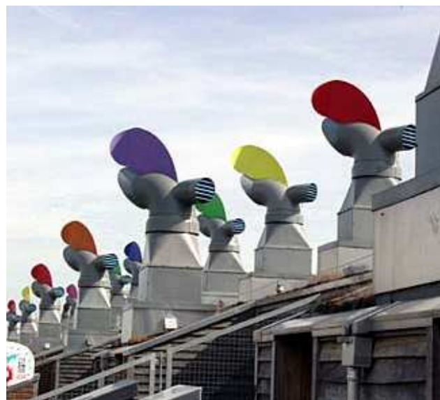
Img.11— Particolare dei camini
