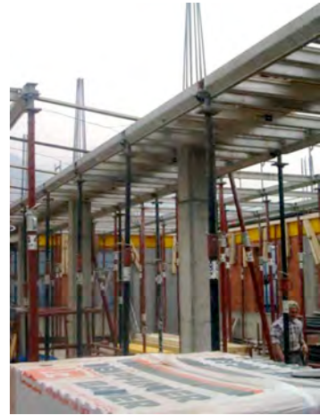
Fig. 311 – Lavori di ampliamento
