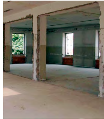
Fig. 310 – Lavori di demolizione
