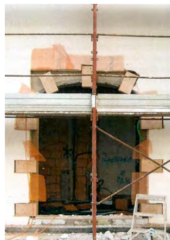
Fig. 338 – Costruzione portafinestra
