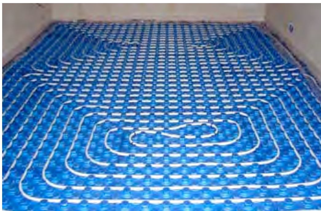
Figura 229 - Impianto radiante a pavimento - fonte biohaus
