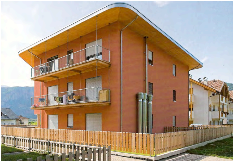
Fig. 297 – Vista da nord
