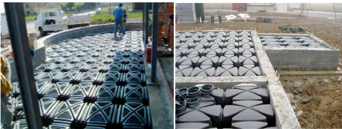
Fig. 355 – Realizzazione della platea aerata in cemento armato su due livelli, a quota del terreno per l'accesso al garage e a quota +85 cm per l'accesso alla zona giorno
