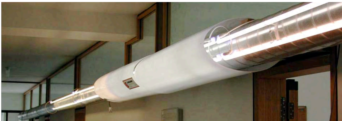
Fig. 320 – Particolare delle condutture d'areazione nei corridoi trasformate in lucernari
