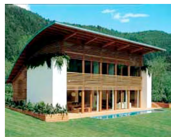
Fig. 248 – Vista da sud ovest
