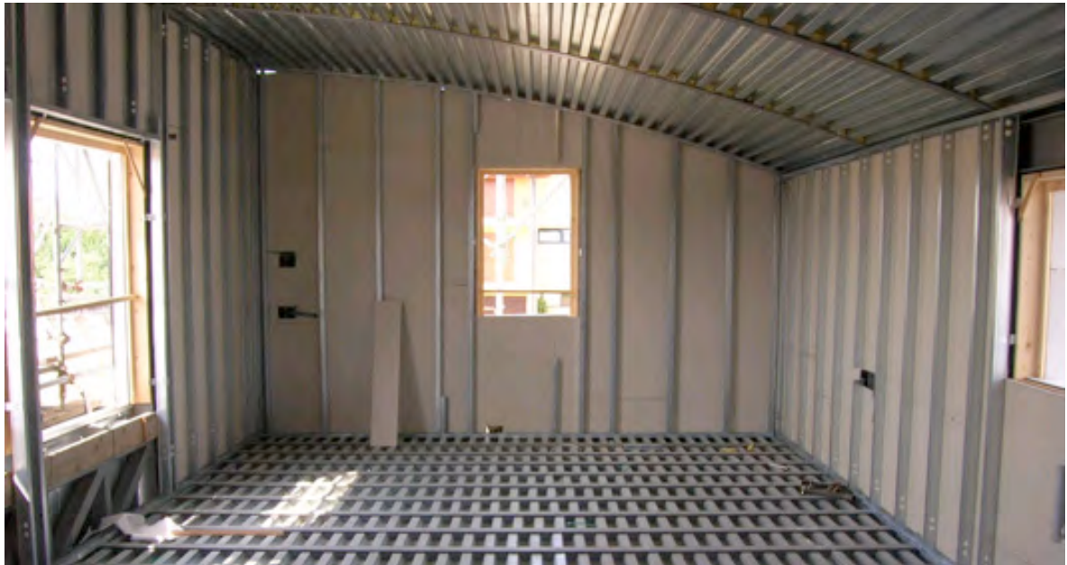
Fig. 359 – Realizzazione della controparete interna per il passaggio degli impianti (vista del piano primo)
