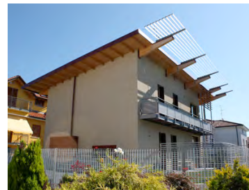
Fig. 141 – Vista facciata ovest
