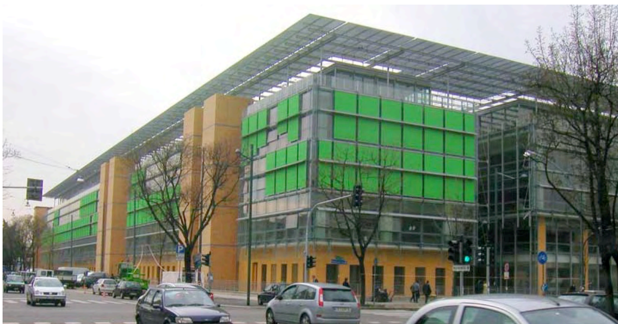
Figura 53 - Le schermature nella sede del Sole 24 Ore a Milano - fonte Renzo Piano Building Workshop
