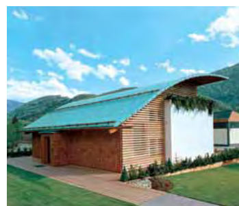
Fig. 250 – Vista da nord ovest
