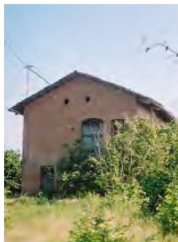
Fig. 266 – Vista del fabbricato rurale (fronte nord)
