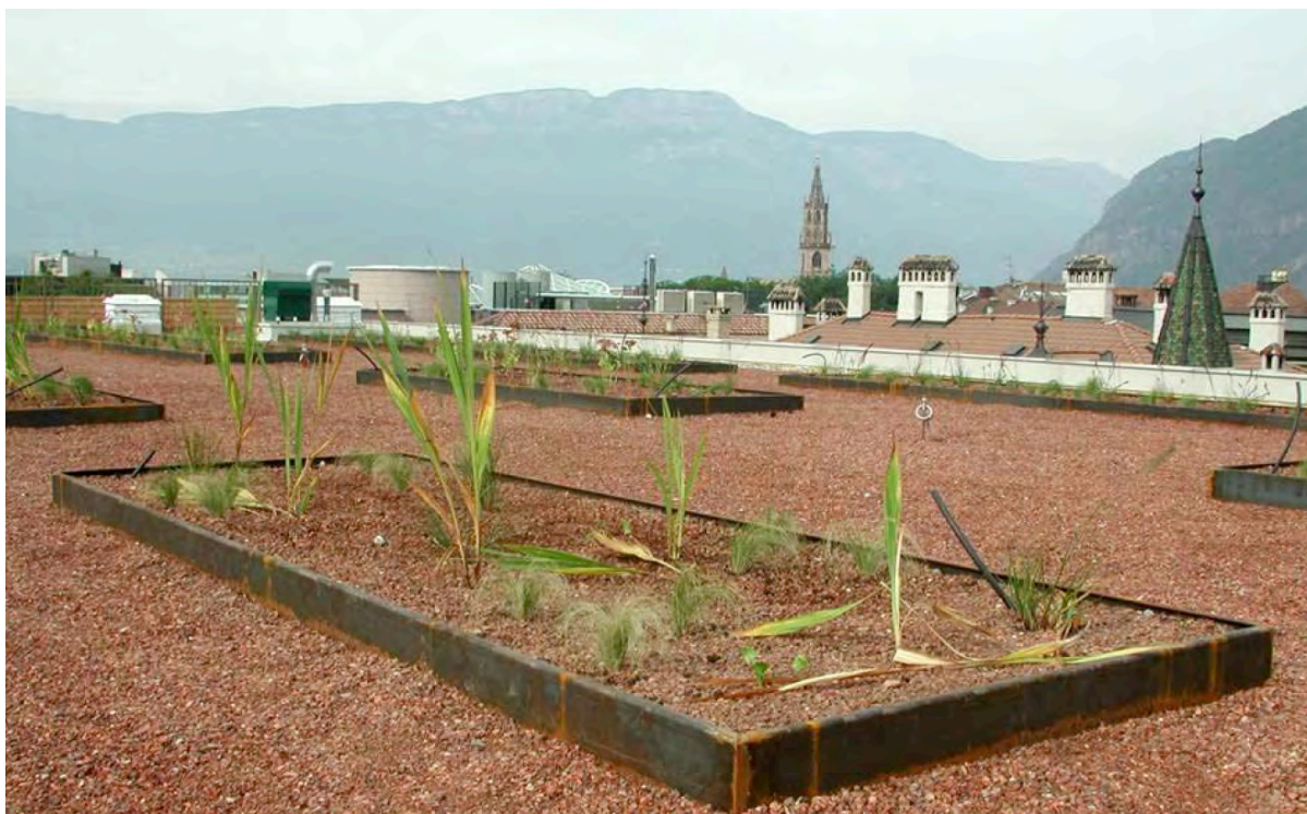
Fig. 244 – Il tetto verde dell'ex Palazzo delle poste (BZ) - fonte delle immagini Michael Tribus
