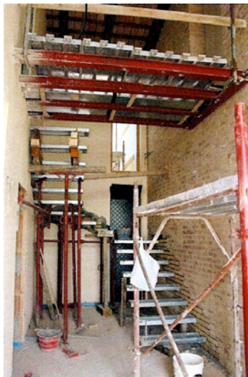
Fig. 341 – Costruzione passerella (spessore 12 cm) e scala a sbalzo
