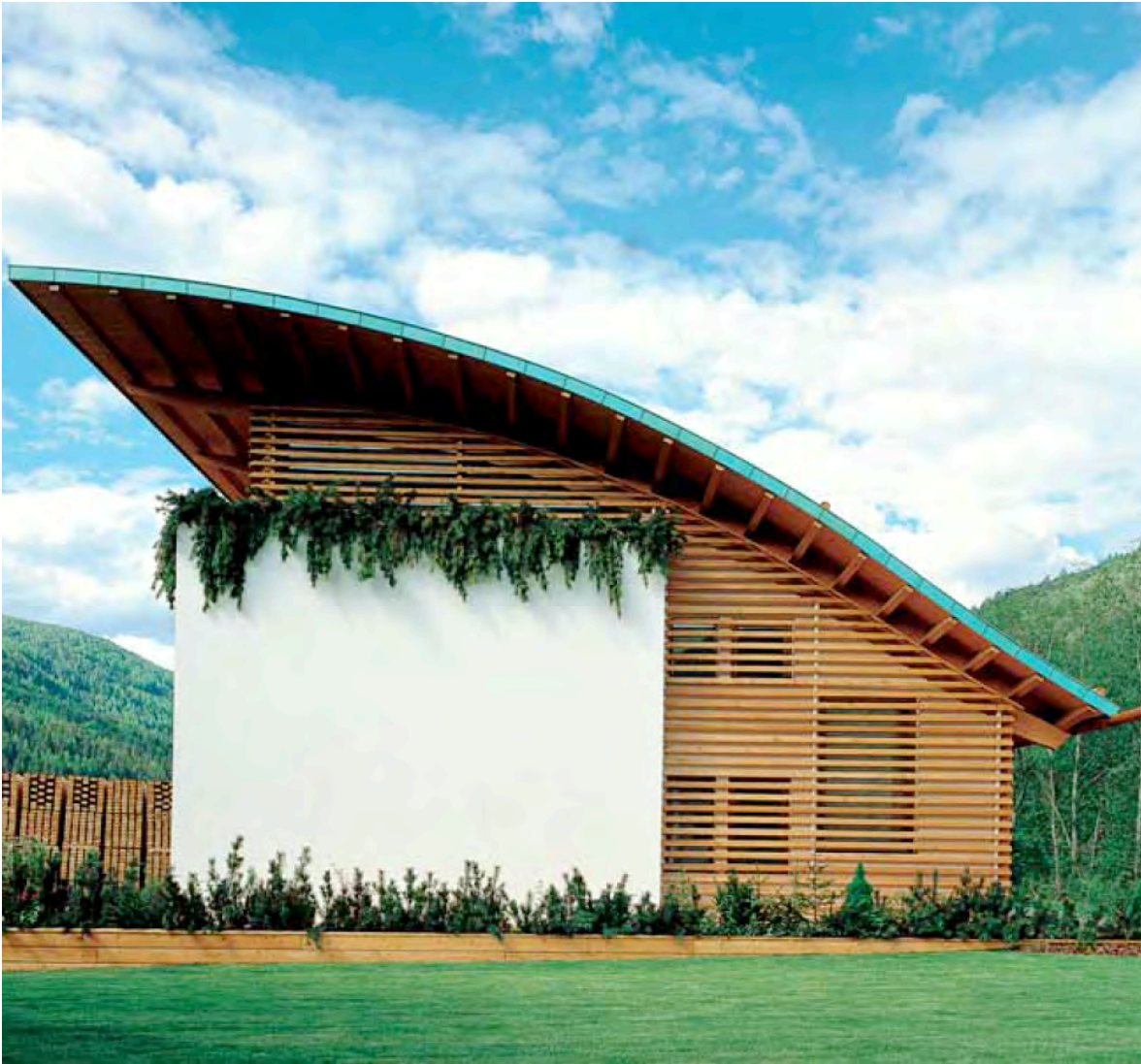
Fig. 256 – Vista da est con in evidenza la struttura frangisole in larice
