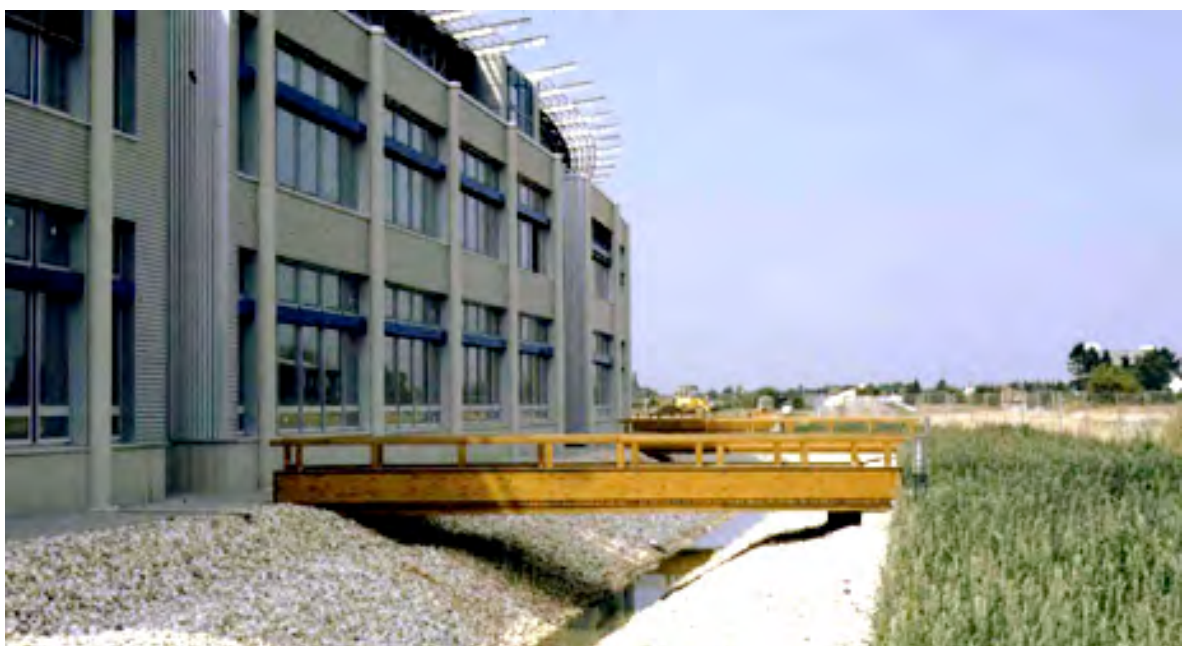
Fig. 172 – Fossato per il recupero dell'acqua piovana - fonte delle immagini Euleb
