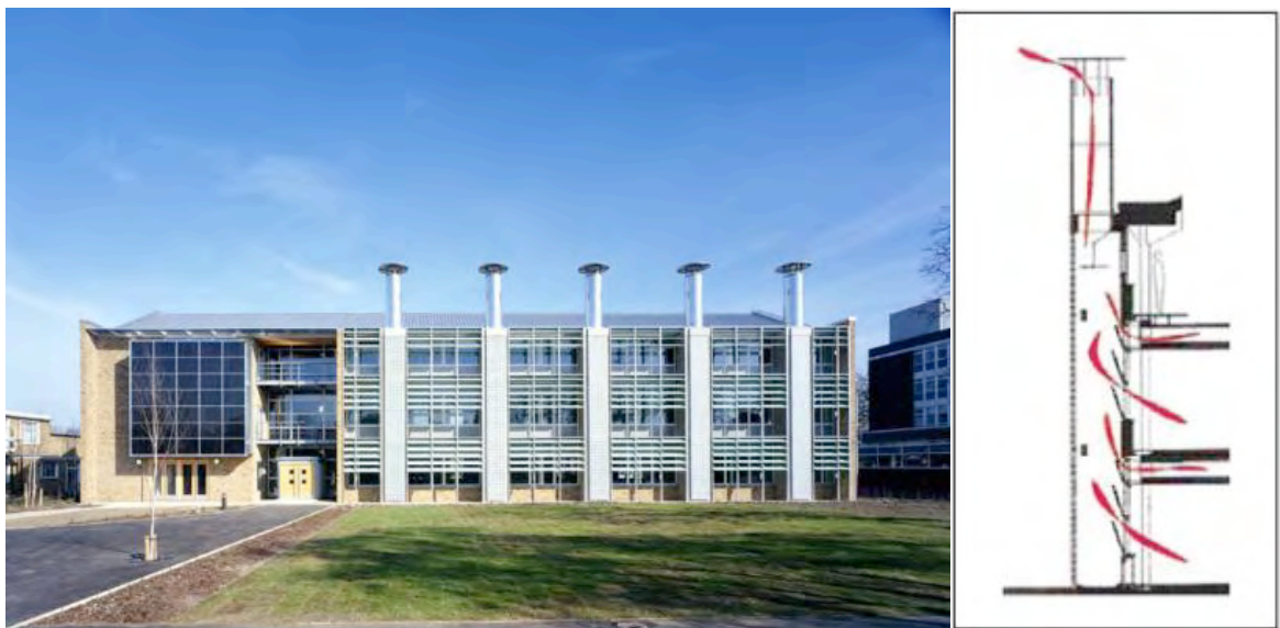
Figura 71 - Camini solari realizzati nel Building Research Establishment a Garston - fonte fcbstudios
