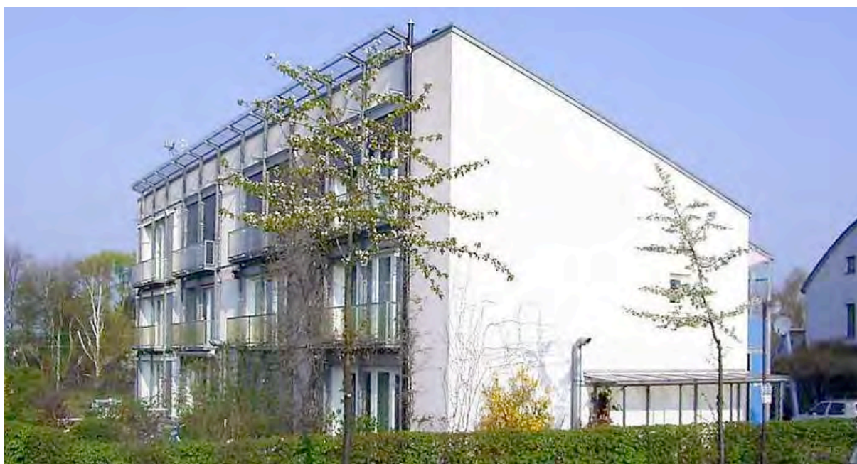
Figura 181 - Il condominio costruito a Darmstadt nel 1991- fonte Passivhausinstitut
