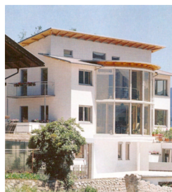
Fig. 260 – Vista da sud ovest
