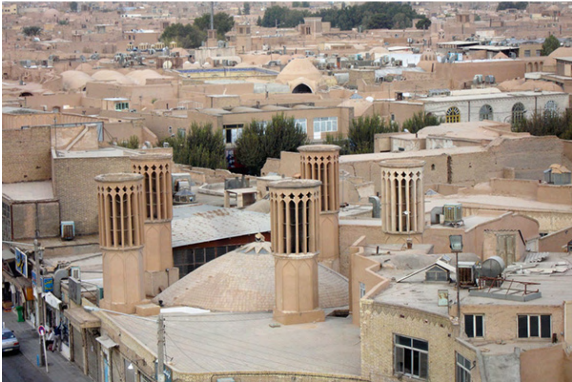
Figura 11 - Torri del vento a Yazd - fonte www.paesieimmagini.it
