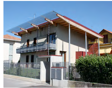
Fig. 139 – Vista da sud-ovest
