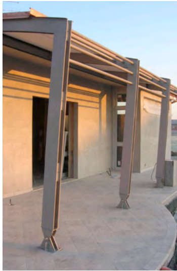
Fig. 349 – Sistemi schermati su struttura autoportante
