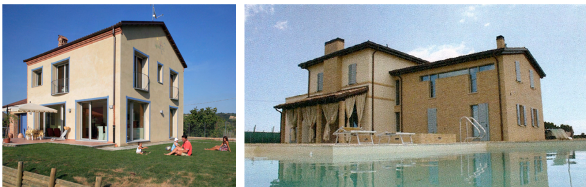
Fig. 246 – La Passivhaus di Cherasco (a sinistra) e di Forlì (a destra) - archivio personale
