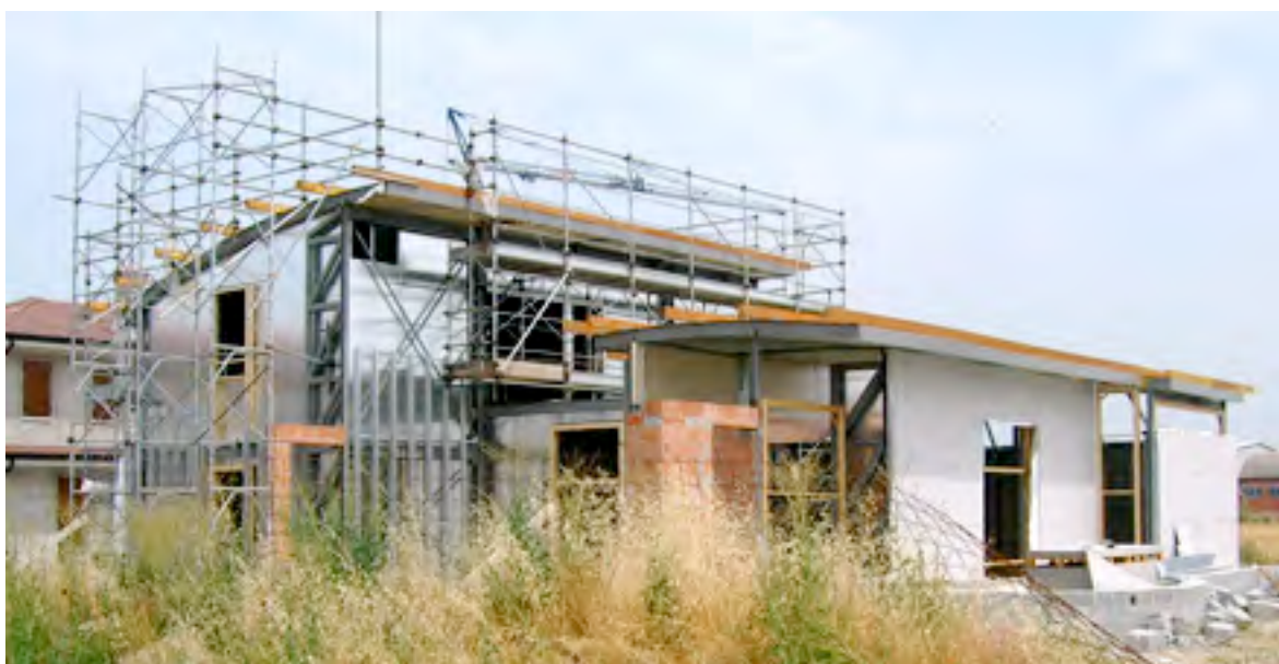
Fig. 357 – Tamponamento a secco con pannelli in fibrocemento Aquapanel
