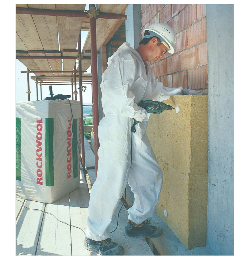
FISSAGGIO MECCANICO DEL PANNELLO TRAMITE TASSELLI
