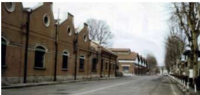
Figura 8 Viale principale edifici AEM
