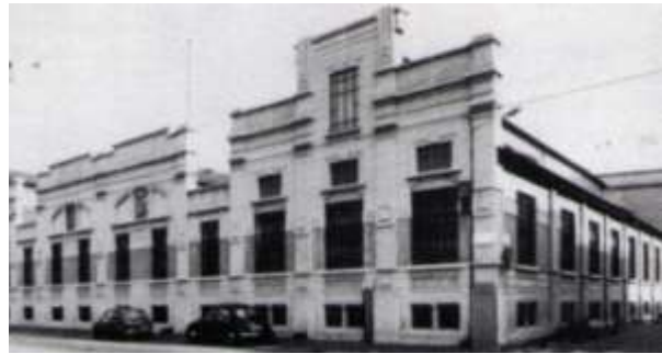
Figura 13 Edificio della Moretti
