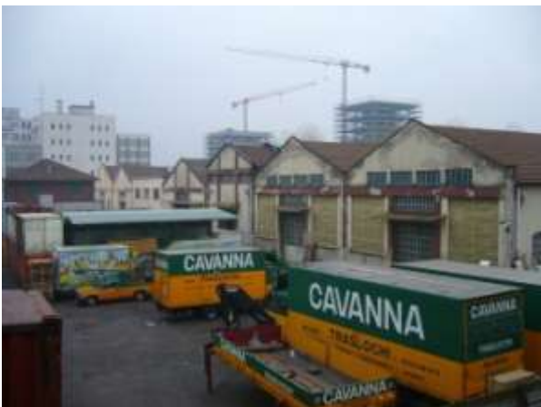
Figura 44 Le facciate dei capannoni
