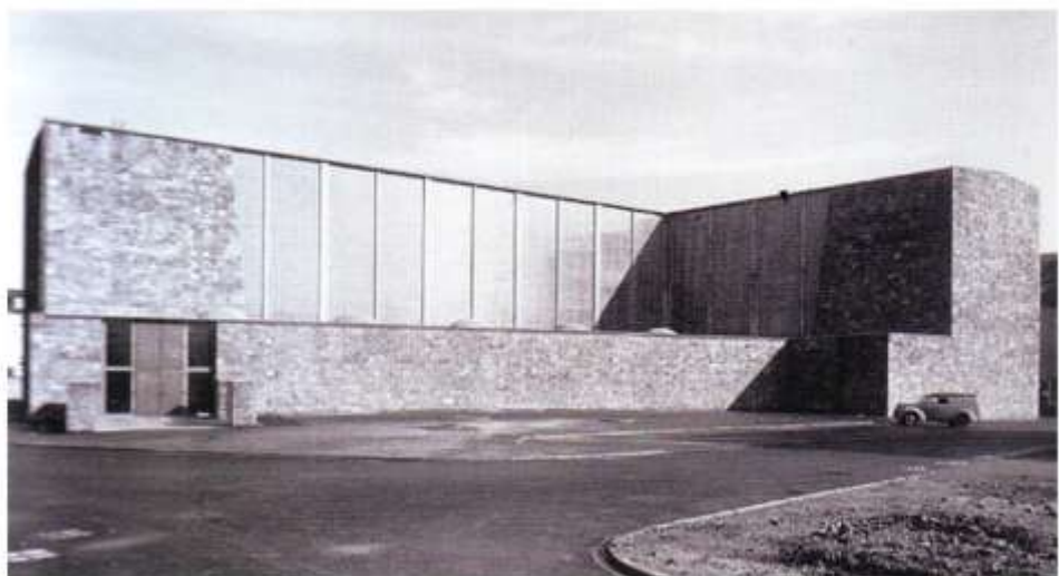
Facciata a Sud
