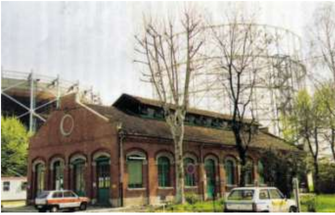
Figura 10 Edificio dell'AEM e gasometri
