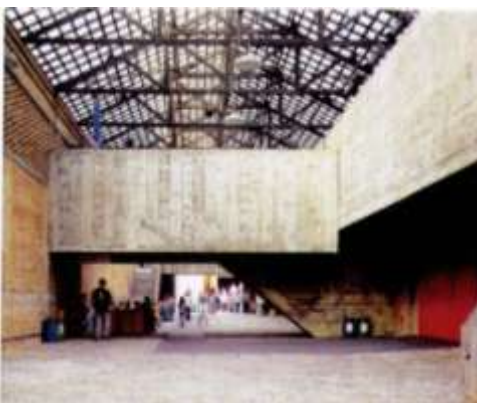
Figura 267 Vista di una passerella
