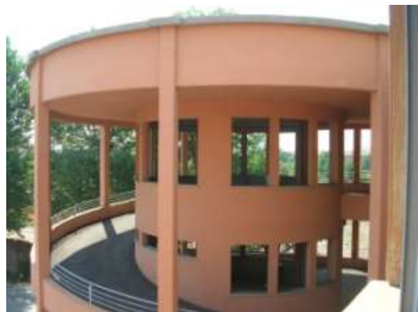
Figura 41 Particolare della rampa
