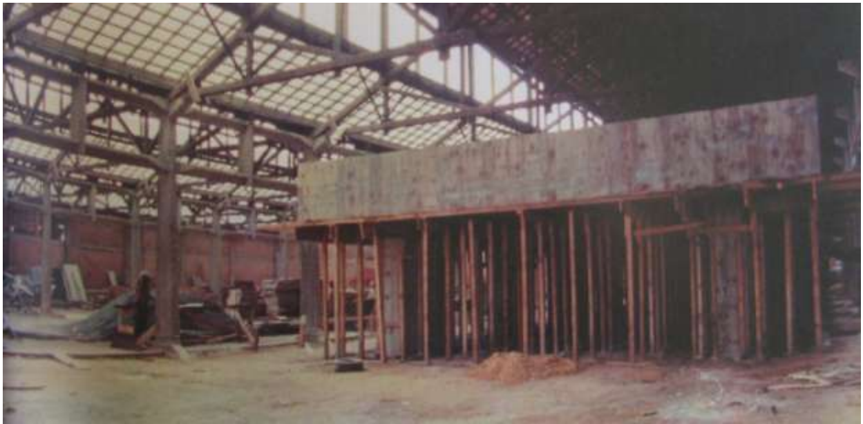
Figura 277 La costruzione dei vassoi
