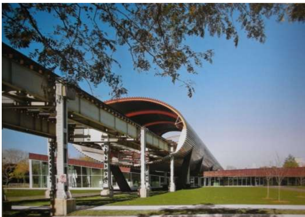
Figura 287 Tubo in acciaio inossidabile che passa sopra gli edifici del campus
