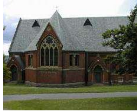
Figura 226 Facciata nord Sage Chapel
