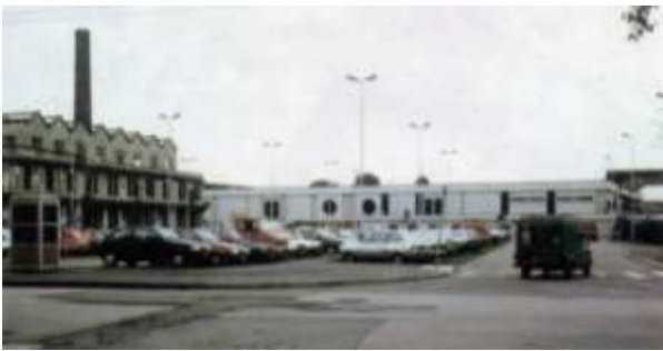
Figura 12 Stazione Bovisa e stabilimento ex Sirio
