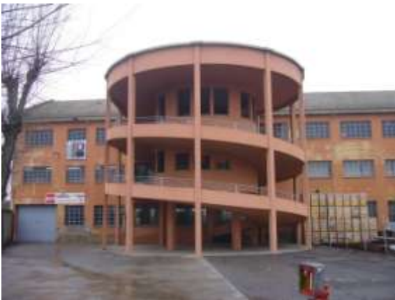
Figura 38 La rampa elicoidale
