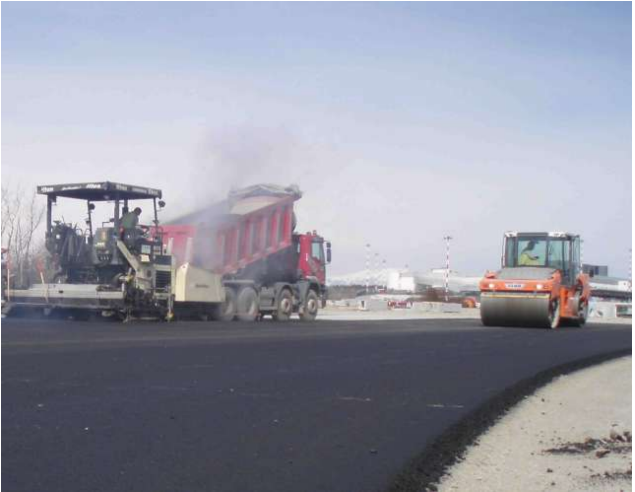
Figura 37: stesa e compattazione dei conglomerati
