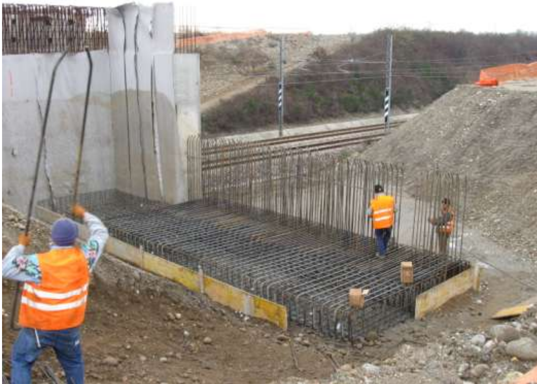
Figura 9: armatura dei muri si spalla
