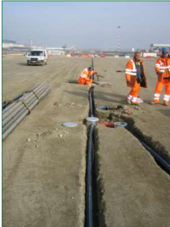
Figura 19: particolare del cavidotto in PCV
