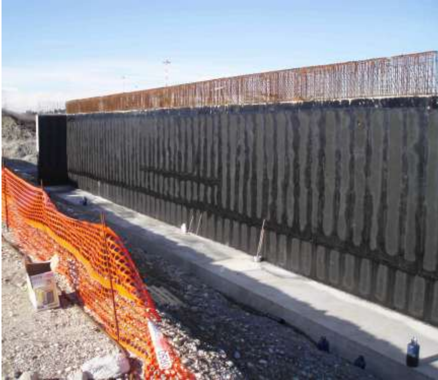
Figura 5: una delle spalle
