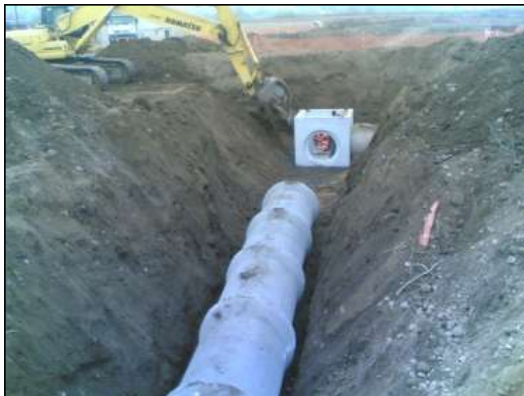
Figura 12: Collettore di scarico
