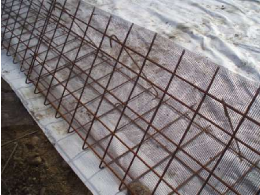
Figura 27: particolare dell'armatura delle terre rinforzate
