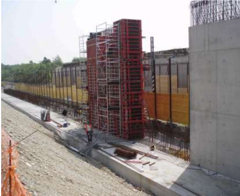
Figura 8: realizzazione delle spalle
