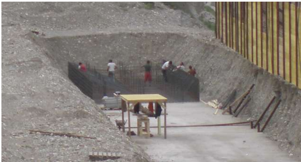
Figura 7: particolare di realizzazione dell'armatura
